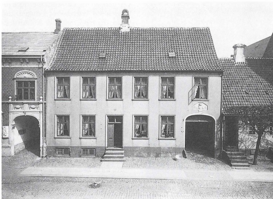
Nørregade 15 i Horsens før bygningen i 1897 blev nedrevet og en ny bygning opført. Det var i denne bygning, at de Hollandske kedelførere havde deres hovedkvarter; den katolske kirke ligger til højre for ejendommen. Fritz Altens samling, Lyngby-Taarbæk Stadsarkiv.
