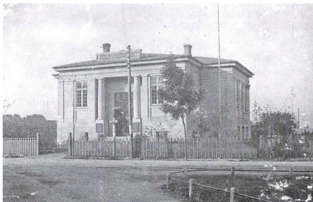
Lyngby Tekniske Skoles bygning fra 1903. I 1910, da fotografiet blev taget, lå skolens bygning i niveau med Jernbanevej og i frie omgivelser, som billedet viser; men efter udgravningerne til viadukten på Buddingevej omkring 1920 kom bygningen til at ligge højt og majestætisk.
