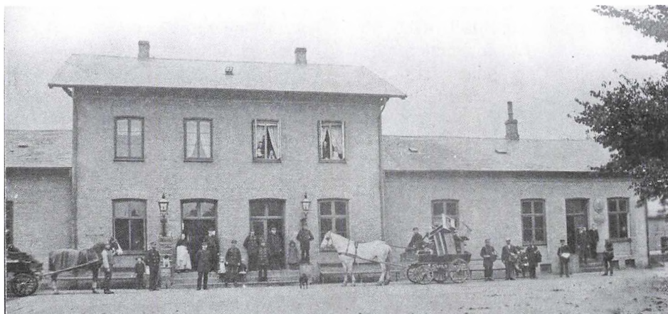
Den første Lyngby Station set fra stationspladsen. Til højre ses den forlængede nordfløj med postkontoret. Billedet er sandsynligvis fra 1891, hvor inventaret er ved at blive flyttet hen til det nye posthus.
