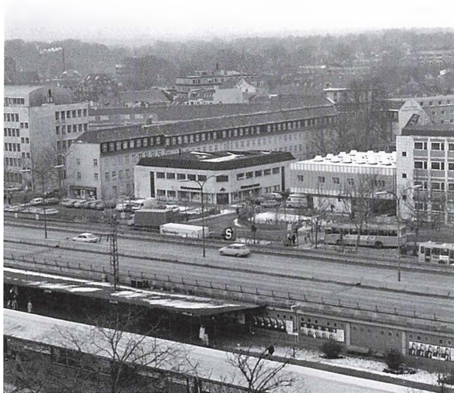
Ejendommen Jernbaneplassen 14-20 (med fladt sort tag) blev opført i 1985 til Rådhusapoteket og Kreditforeningen Danmark, men rummer nu Arbejdernes Landsbank og FOF's undervisningslokaler. Foto 1986.
