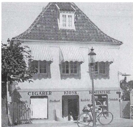
Skræddermester Lykkes Hus fra 1918 (Jernbanevej 27A, senere 33), fotograferet 1923.
