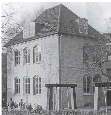
Den katolske forsamlingsbygning fra 1938. Fotografiet er fra 1950'erne, hvor bygningen anvendtes som fritidshjem.
