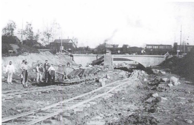
Udgravningsarbejdet til viadukten på Buddingevej ca. 1920. Et nordbanetog passerer hen over broen på vej mod Holte.
