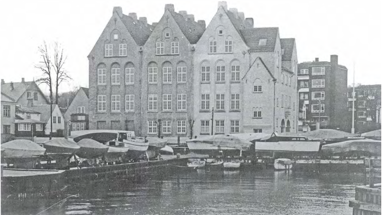
På billedet af Taarbæk skole efter 1957 kan man se, hvordan skolen er bygget ad tre omgange. Den midterste er fra 1914, den venstre fra 1931 og den højre fra 1958, hvor man genskabte indgangspartiet med trappetårne til skolen. Arkitekt på den første etape var Aage Lønborg-Jensen. Arkitekt A. Heilbo tegnede udbygningen i 1958.
