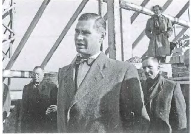
Borgmester Fenneberg ved rejsegildet på højhuset på Lyngvej. Til venstre kommuneingeniør J. A. C. Rastrup.
