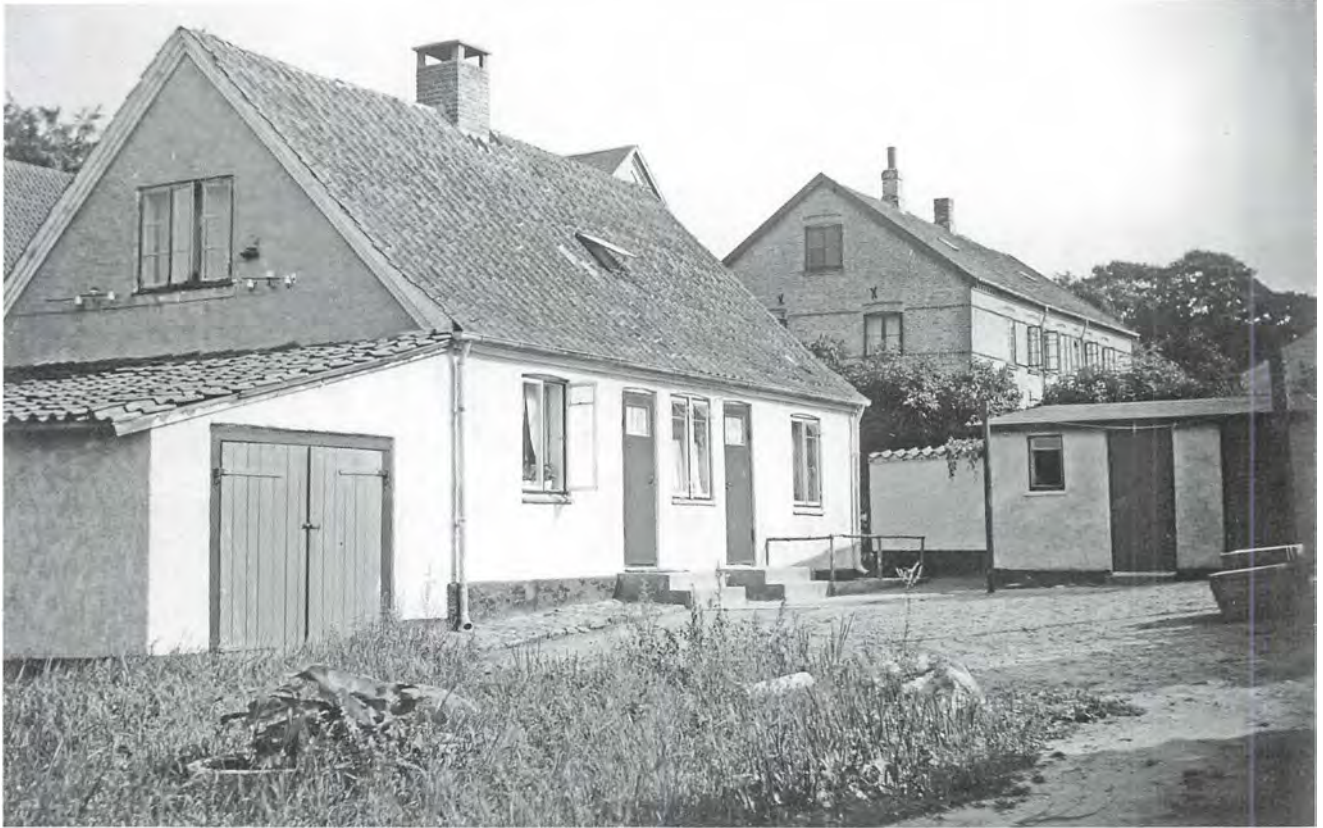
Der blev lagt indlagt kloak og ét wc til deling for de to lejligheder i dette gamle landsbyhus i Lundtofte Skolestræde i 1956. Huset er opført i 1862.
