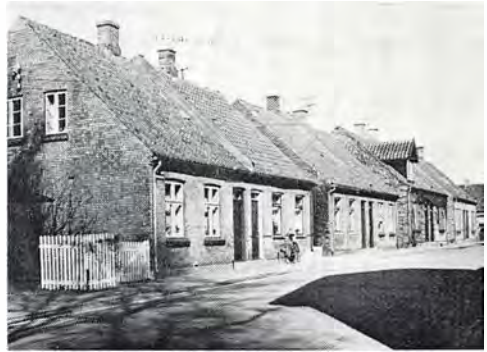
Arbejderboliger i Nørresøgade opført 1898-99 til AIS Pentz Møllers arbejdere. – Foto 1966.
