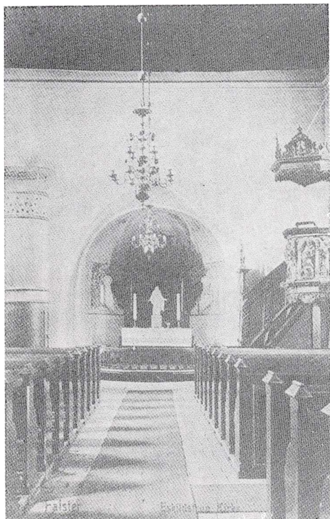
Eskilstrup kirke. Dengang var der en stor kamin i kirken, for at man kunne holde varmen. Kaminen blev stillet op i 1897 og brugt indtil midt i 1920'erne, da måtte man stille et andet varmeapparat op. (Foto: Falsters Minder).
