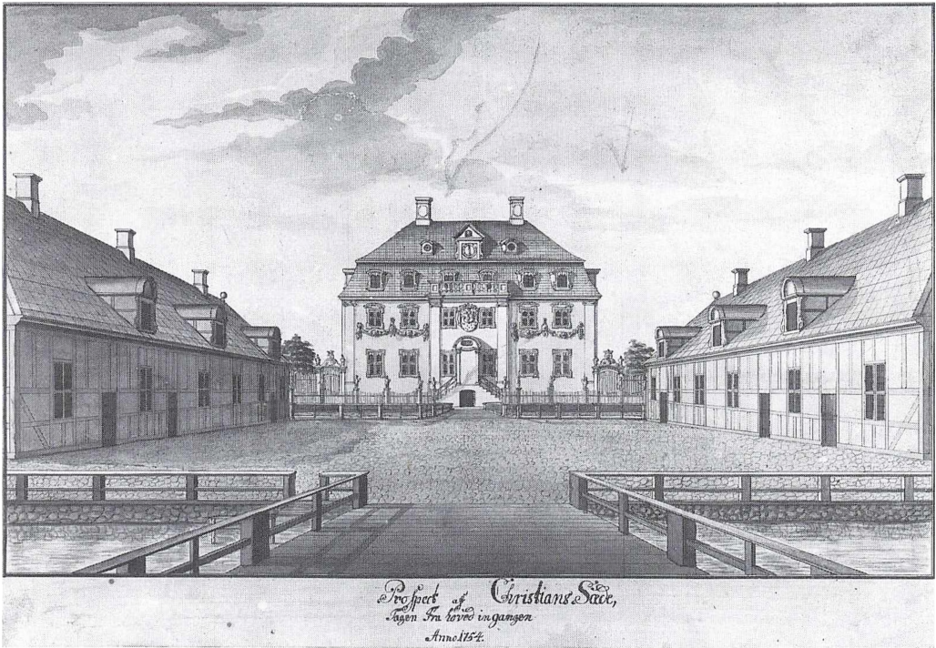
Christianssæde, prospekt fra 1754. Hovedbygningen er fra 1690, mansardetagen tilføjet o. 1740. Avlsbygninger på billedet brændte 1851, hvorefter avlsgården opbyggedes på den anden side af vejen. Hovedbygningen brændte 1979, i dag genopbygget uden mansardetagen. Frederik Vs Atlas.
