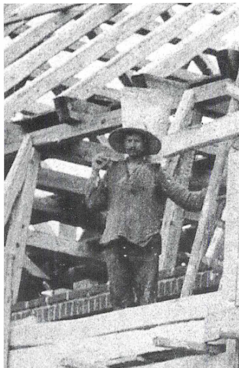
Arbejdsmand med mørtelspand – også kaldet »høj hat«. – Detalje fra billedet på modstående side. Foto: Lolland-Falsters Stiftsmuseum.
