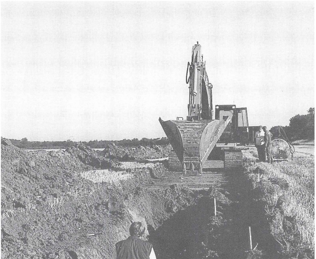
Fig. 3. (arbejdsbillede med den store profilskovl) Kabelgrøften graves igennem Bøtø Nor 1993.
