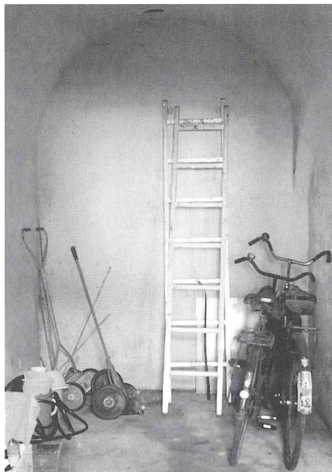
5. Den fundne bunker fra flyvepladsen på Bøtø. Det har ikke været muligt nærmere at undersøge vægge og lofter, men det må formodes, at væggene er af beton (tykkelsen kan ingen steder måles direkte), og at loftet er af mursten. Ovenpå ligger et tykt lag sand.
