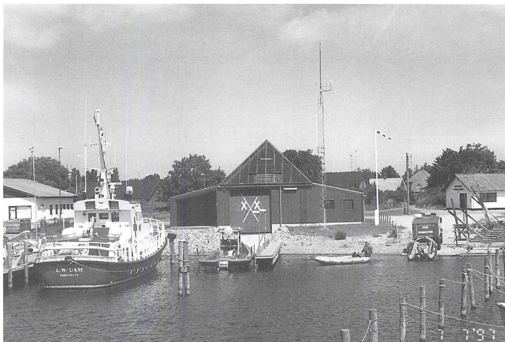
Det nye redninghus, færdigbygget december 1991 af Frydkjær Totalentreprise, Roskilde. I havnebassinet ses tv. stationens nyeste redningsbåd »L.W. Dam«, midt for agter fra XRB 10, samt th. gummibåd og trailer.
