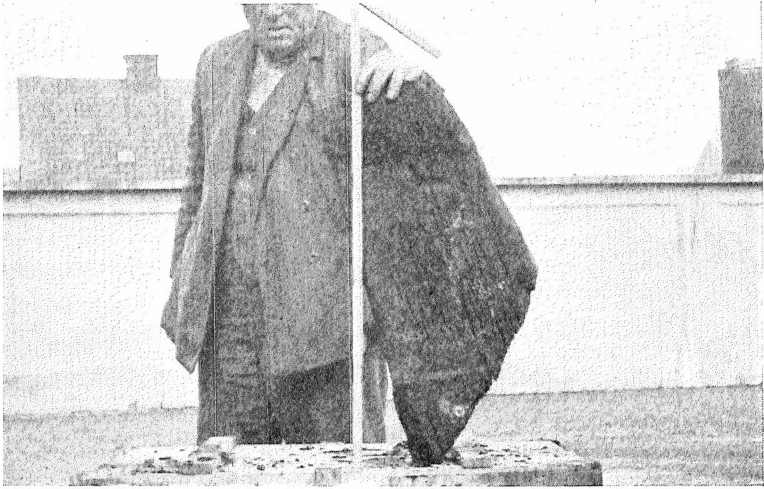
Spuns ved Agterstævnens Hæl, fotograferet i dens omtrentlige Stilling paa Stævnen. Aftryk af Beslag for Agterstævnsror er tydeligt.
