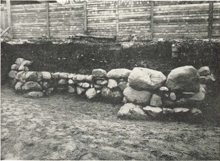
Fig 2. Korets Østgavl set fra Øst. Fundamentet gravet fri i hele Dybden.
