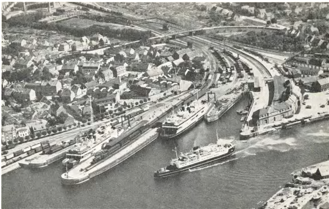
Flyverfotografi af færgelejerne, set fra sydvest. Postdampskibene klarede trafikken, indtil dampfærgedriften begyndte i 1883. De tre færgelejer ud mod Bæltet blev anlagt 1883–1906, og hertil kom i 1930 et bilfærgeleje syd for den nye statsbanestation t. h., som i 1907 havde afløst banegården inde ved den gamle havn. (Fot. 1947 Nowico).
