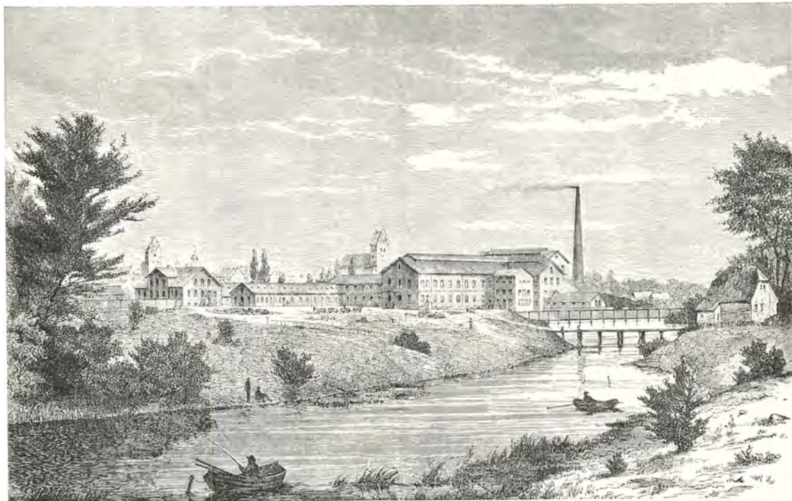
Maglemølle papirfabrik ved Næstved. Virksomheden, der startede i 1875, var anlagt på det sted, hvor den gamle Maglemølle havde sin plads. Som drivkraft brugtes dels damp, dels Susaaens vand. (Træsnit i Ill. Tid. 1874-75).
