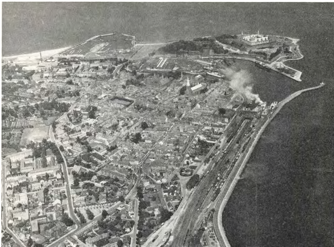
Flyverfoto af Helsingør, set fra sydvest. Havnen, der vanskeligt fryser til, er udvidet flere gange mellem 1827 og 1945. Den nye havn nordvest for Kronborg blev anlagt i 1930'erne. I den gamle bydel ses bl. a. Skt. Marie kirke og Skt. Olai kirke. Den sidste fik først sit nuværende spir i 1898. (Fot. 1952 Aero Luftfoto).
