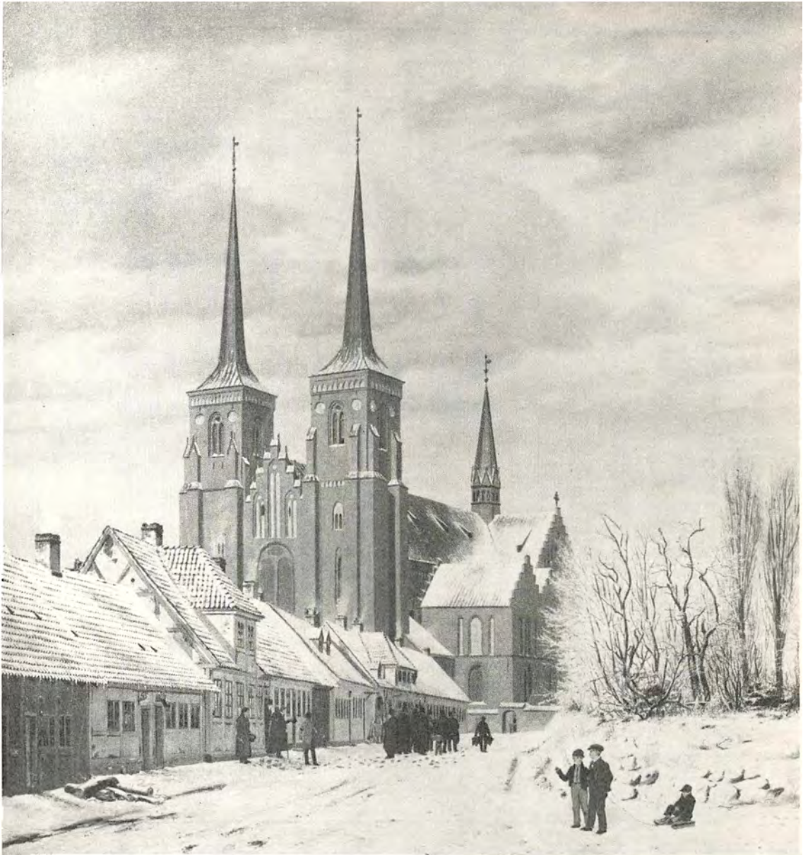
Roskilde domkirke, vor skønneste og ejendommeligste domkirke, fransk i sin oprindelse, dansk i sit materiale, præget af en organisk udvikling gennem 300 år; skønt det ikke kan ses i det udvendige, er sydtårnet romansk, men nordtårnet er fra gotisk tid; de slanke spir er fra Christian 4.s tid, Margrethe-spiret fornyedes 1656; det lille halvtagsdækkede våbenhus har oprindeligt haft kamtakkede gavle; bag det ses Helligtrekongers togavlede kapel, og bag det igen rager søndre korsarm op. Frederik 5.s kapel ses ikke. (Efter maleri 1836 af Jørgen Roed).
