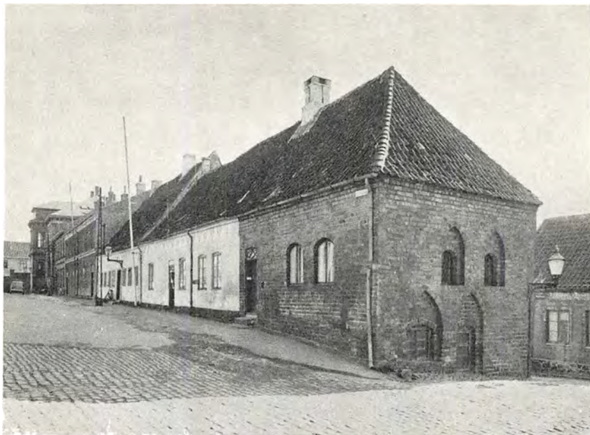
Stenboderne syd for Skt. Peders kirke er opført i middelalderen. De erstattede kirkegårds-muren på det stærkt skrånende terræn, der bevirkede, at de fik to stokværk mod strædet i syd, mens de kun har et ind imod pladsen. Fra flagstangen til den høje bygning i baggrunden ligger borgmester Mogens Thuessøns stenboder, der er opført i det 15. århundrede som boliger for syv småhandlende eller håndværkere. (Fot. 1955 N. Elswing).
