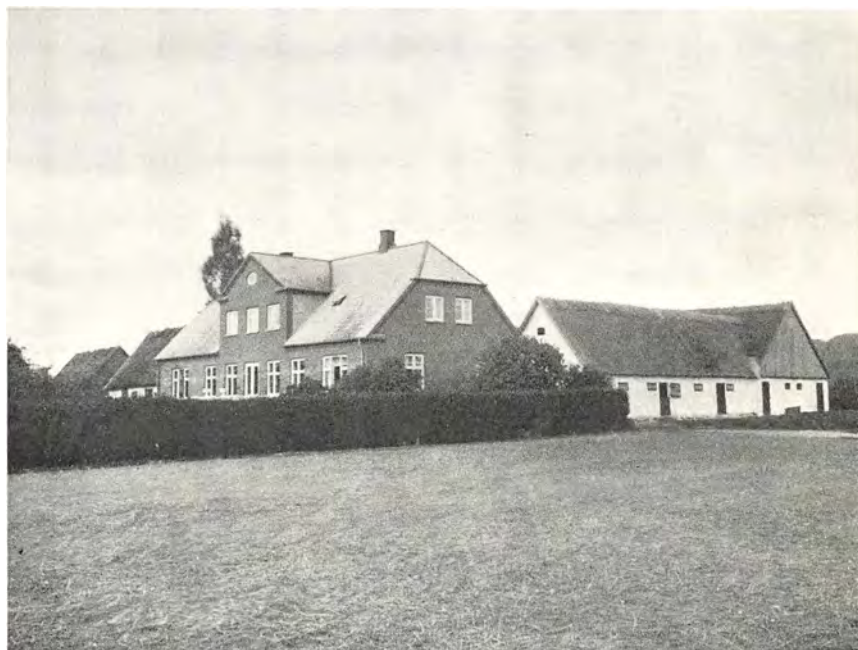
Udflyttet gård i Pebringe nord for Fakse. Stuehuset er et moderne rødstenshus, medens udlængerne er opført i bindingsværk. (Nationalmuseet. Fot. 1940 Axel Steensberg).
