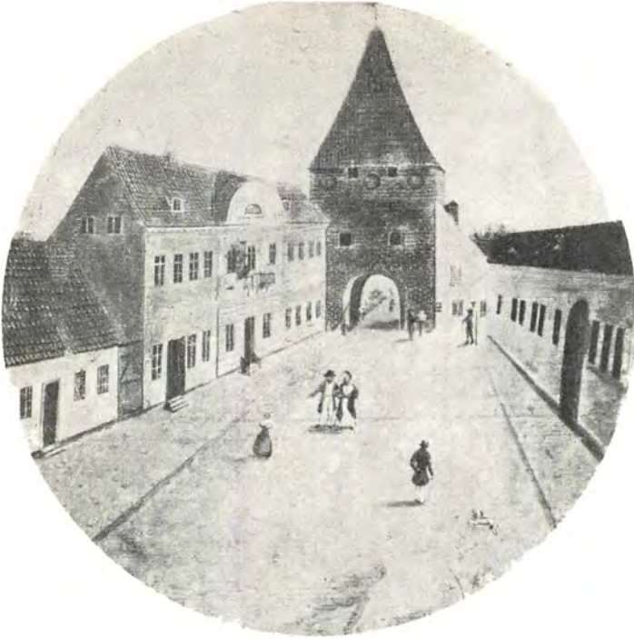
Til venstre: Mølleporten og den nordlige del af Møllegade, nu Storegade, i 1837. Acciseboden t. h. for tårnet blev fjernet o. 1895, for at den voksende trafik kunne ledes udenom den gamle fredede bygning, der er landets bedst bevarede middelalderlige byport. (Efter fot. af skydeskive. Nationalmuseet).
