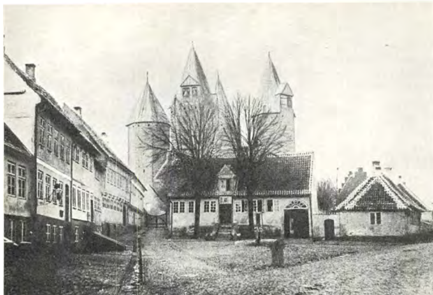
Parti af Adelgade o. 1865. Kirkens midtertårn mangler. Det var styrtet ned en septemberdag i 1827 som følge af, at man gennem århundreder havde svækket pillernes fundamenter ved de mange begravelser under kirke- gulvet. I 1866 bevilgede staten ca. 44.000 rdl., og byen skød andre 10.000 til, hvorefter kirken restaureredes 1867-71. (Fot. P. W. C. Timm).
