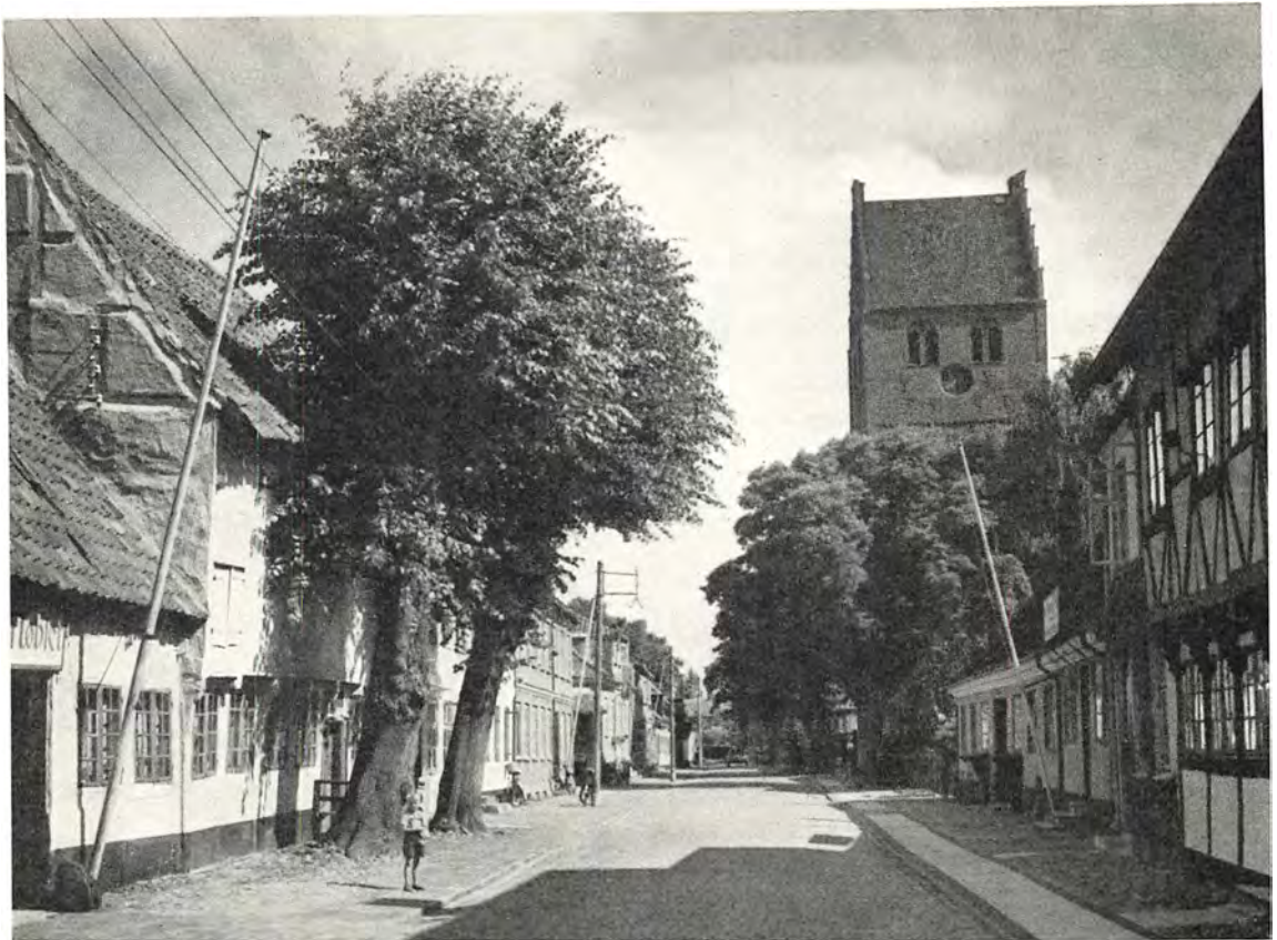
Kirkestræde set fra syd. Bag de to store træer til venstre ligger Smedegaarden, en bindingsværksbygning, der menes opført i første halvdel af det 16. århundrede, med to bislagssten fra o. 1520 foran indgangsdøren. (Fot. Herluf Lykke).
