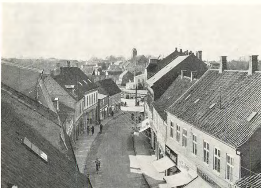
Algade i dag, set fra øst. Gaden, der nu er asfalteret, blev brolagt 1817, men med toppede sten, som først i 1870'erne afløstes af tilhuggede. På hjørnet ved havnen ses et bindingsværkshus fra o. 1650, der blev restaureret i 1954. Heroverfor opførtes i 1898 en høj bankbygning, som har taget en del af udsigten til højre. (Fot. 1955 N. Elswing).
