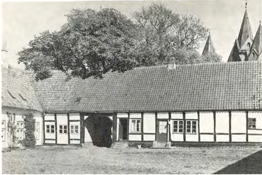
Østfløjen i Lindegaarden, en en-etages, seksfløjet bindingsværksgård, som skal være opkaldt efter lensmanden Hans Lindenov, Christian 4.s svigersøn, der overtog den i 1656. Kun en af ejendommens længer kan dog stamme fra hans tid. Resten er fra det 18. århundrede. Bygningen er nu indrettet til museum. (Fot. Kalundborg Turistforening).
