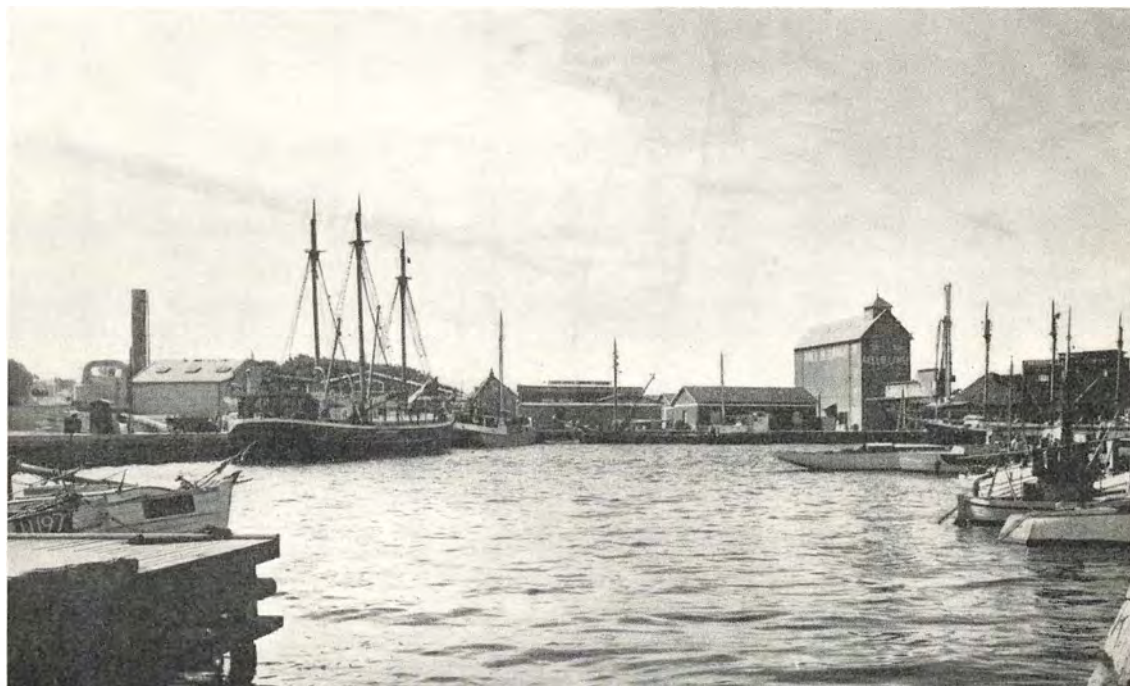
Herunder: Parti af havnen i dag. Den første havn fra 1843 var meget beskednen og måtte udvides adskillige gange, før den blev helt bygget om i 1915. I 1927 fik den endelig sin nuværende vanddybde på 5,2 m. Møllen er kloakvæsenets pumpemølle. (Fot. 1953 Helmuth Hansen).
