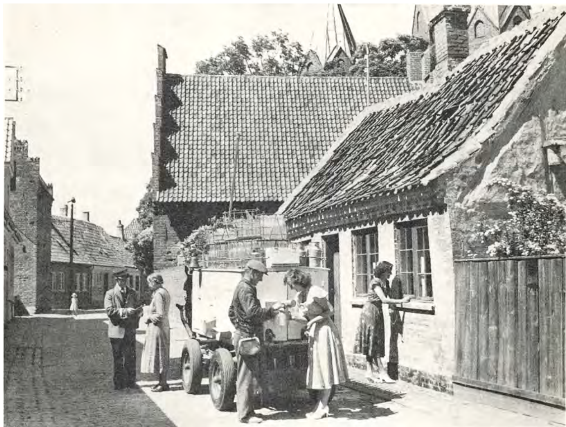
I Præstegade ligger to middelalderlige bygninger med kamtakkede gavle. Til højre, i kirkegårdens sydøstre hjørne, ses den gamle kirkelade, en tid benyttet som latinskole og efter dennes nedlæggelse i 1739 anvendt til forskellige formål. Den er nu restaureret ligesom det høje munkestenshus overfor. (Fot. Kalundborg Turistforening).
