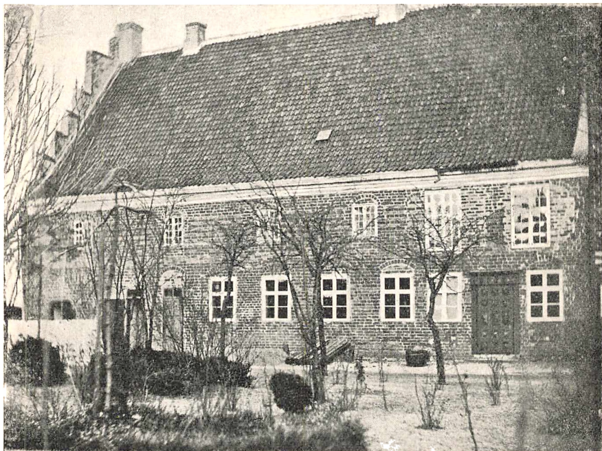
Afb. 8. Raadhusfløjens Vestside før 1874.
