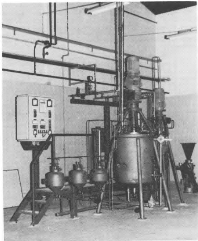
Figur 4. Fermenteringsanlæg med 500 l hovedtank. Bioteknisk Instituts tekniske forsøgsanlæg.
