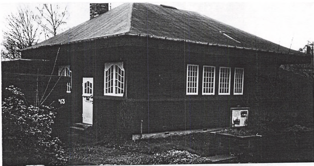
Stokholmsvej 43, som det ser ud i 1994. Huset var tidligere Trafikmestervagt, ventesal, billetsalgssted og offentligt toilet på Rådhuspladsen i København.
