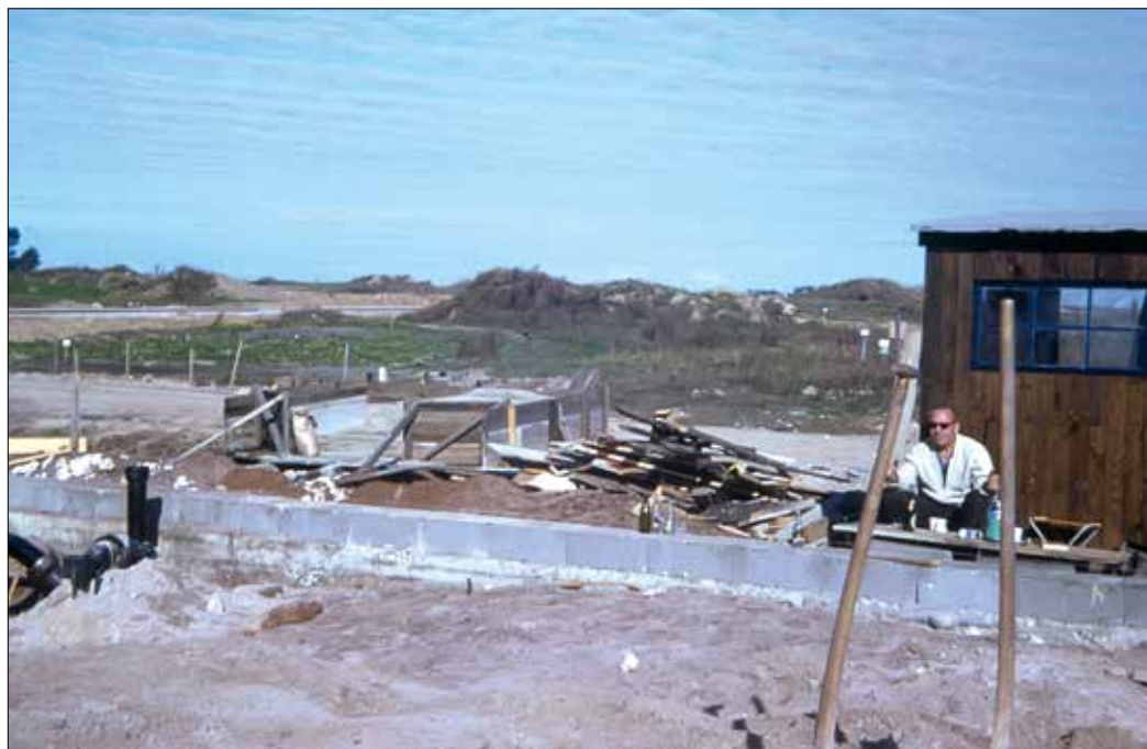
Fundamentet er støbt, og onkel Vagn slapper af oven på veludført arbejde. Bagved ses det helt nødvendige skur til redskaber m.m. Foto i familiens eje.
