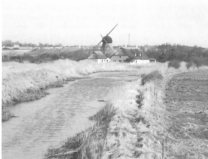
Fig.11 viser pumpe- møllen ved Vitsø. Møllen er et meget betydningsfuldt levn, da den repræ- senterer et forholds- vist tidligt tekno- logisk studie i den danske pumpemøl- lehistorie. Den er den eneste af sin art, som er bevaret i Danmark. Foto: Birgit Bjerre Larsen.
