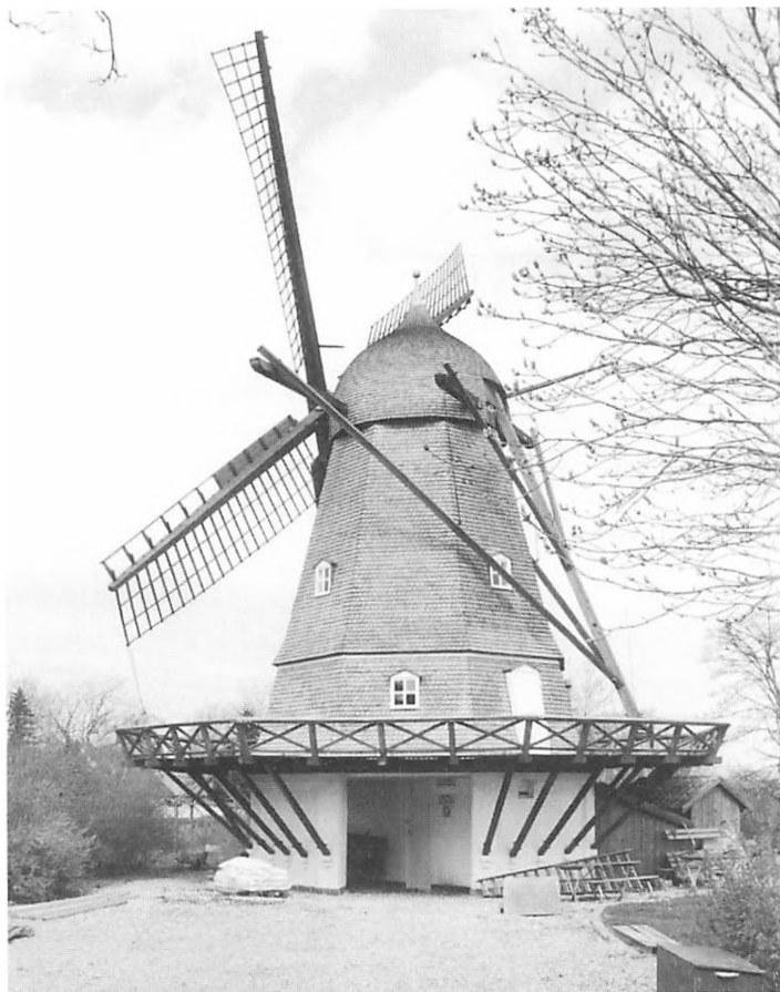
Fig. 13. Øksenmagle Mølle. Møllen er en såkaldt Gallerihollænder. det er en bygning med en overordentlig markant og karakteristisk profil, der står for et kendemærke i landskabet. Foto: Flemming Rasmussen.
