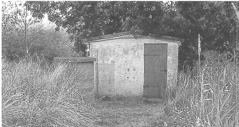
Fig. 19 viser det tredje pumpehus med pumpebrønd til venstre. Huset er er hvidkalket murstenshus med eternittag. Bagved huset findes stadig rester af den gamle betonkanal og jernsnejl, som anvendtes af vindmotoren. Foto: Morten Stenak 1999.
