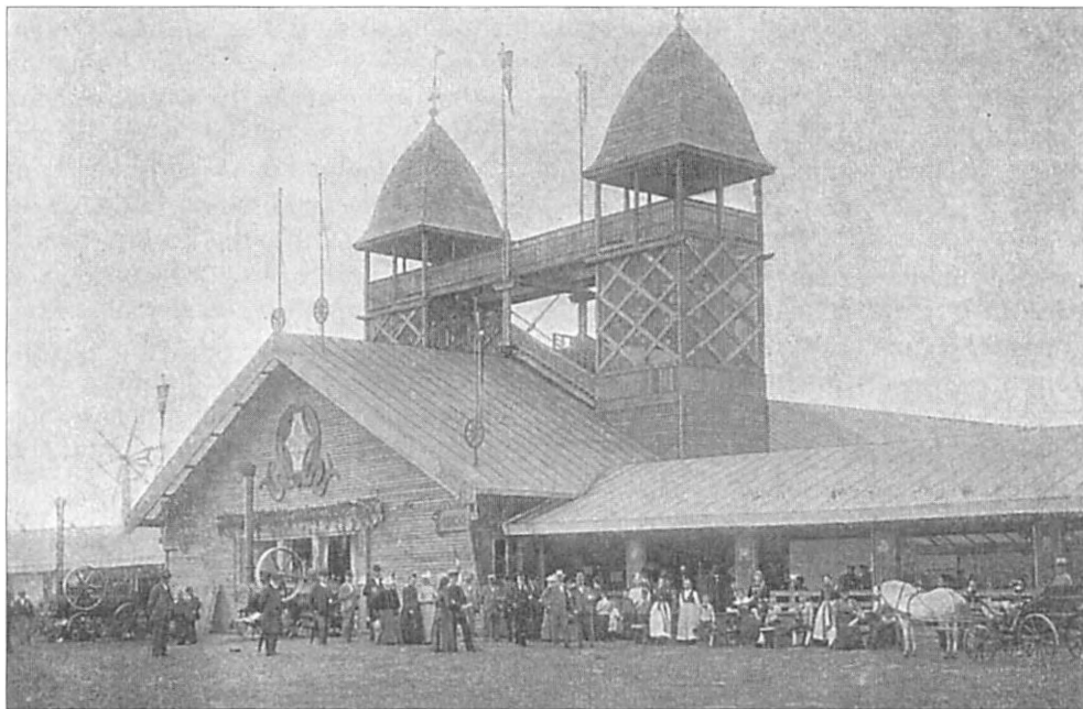
Maskinhallen med dens udsigtstårne. Til højre Eksportslagteriets restauration. ( Beretningen , s. 172).
