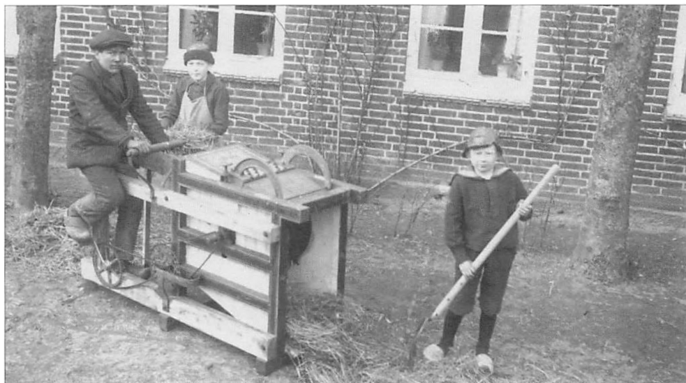
Pedaltrukken pigtærsker konstrueret på Anton Nielsens Maskinfabrik. Billedet er taget uden for Anton Nielsens privatbolig. (Fotografiet er udlånt af Rougsø Lokalhistoriske Forening. Foto: Dørge, Allingåbro).
