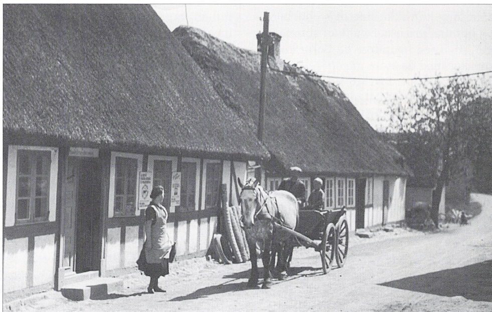
Ved "Maale Brugsforening" på Hindsholm.
