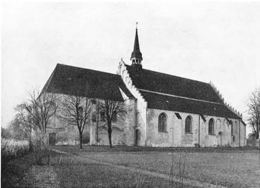
Afb. 7. Kirken, set fra Nordøst. Det lavere og smallere Kor skyder ud fra det højere og bredere Skibs Hovedskib. Baade Korets (jvf. Afb. 8) og Skibets Nordside bærer Spor af Forandringer, der har fundet Sted. (Mathiesen fot.)
