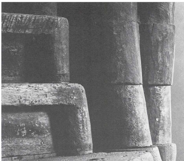
Nærbillede af den tovsnoede spindel og trinforkanterne på trappen på Berritsgaard. Fot. 1978.
