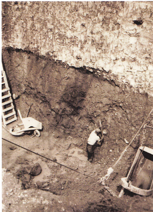
Udgravning til Pumpestation Avedøre vest 1956
