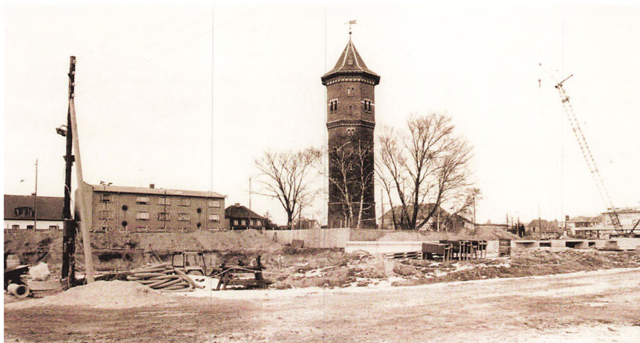
Byggeplads til Siestabebyggelsen 1983.
