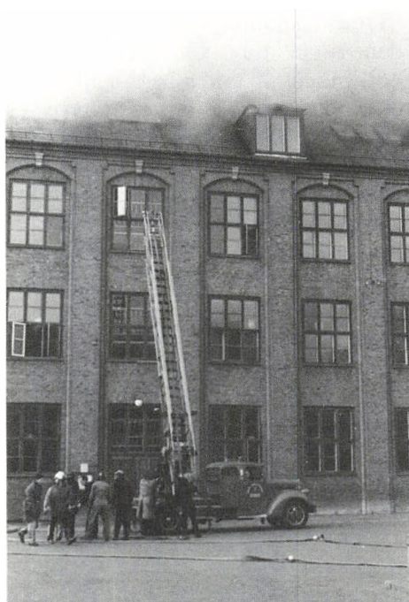
Tagetagen udbrændte, og begge bygninger blev stærkt vandskadede. Bygn. IV og V, 18. februar 1967.
