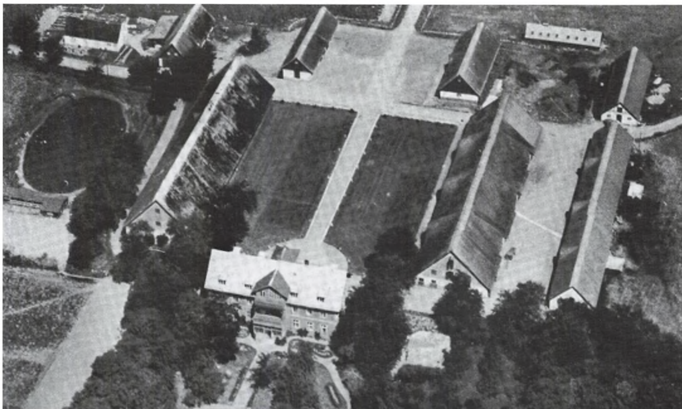
Grønnessegård 1930. K. A. Hasselbalch har forskønnet gården. Bygningen på gårdspladsen er fjernet, møddingen flyttet og brostens-belægning udført.
