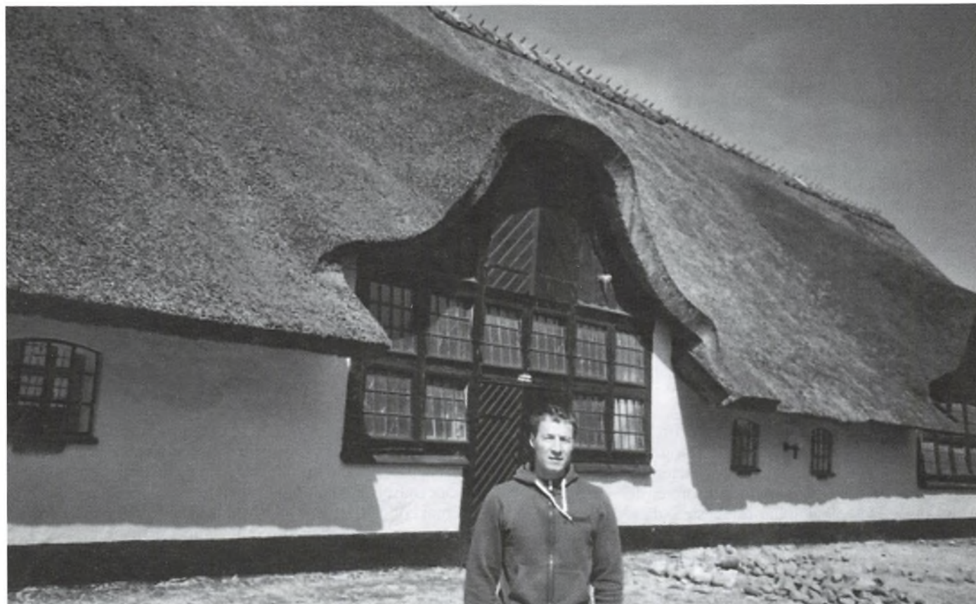
Grønnesegårds ejer, Ditlev Hasselbalch, foran et af de store vinduer som K. A. Hasselbalch satte i kostalden, da han mente at mere lys i stalden ville gavne mælkemængden og mælkens kvalitet. I dag ved vi, at lysmængden i staldene er meget afgørende for dyrenes ydeevne. K. A. Hasselbalch ændrede samtidig kostalden fra en tværstald til en stald med to lange rækker med båse.
