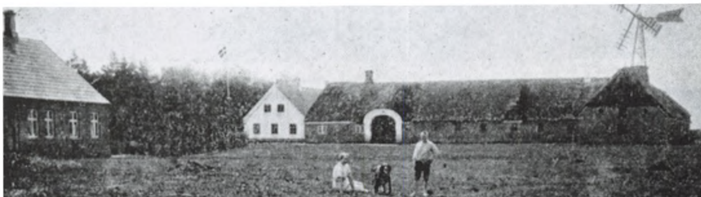
Sønderbygård o. 1910. Gården var oprindelig firelænget med kun en port, og stuehusets vinduer mod syd var forsynede med gitre, der skulle sikre mod ubudne gæster. Et af disse gitre sidder stadig i soveværelset.
