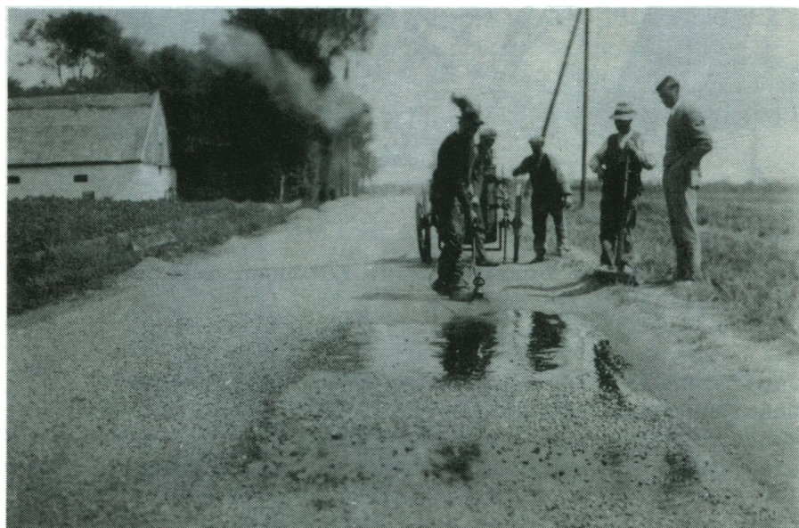
Tjærebehandling af Køgevej i 1927 (den senere Gl. Køge Landevej)
