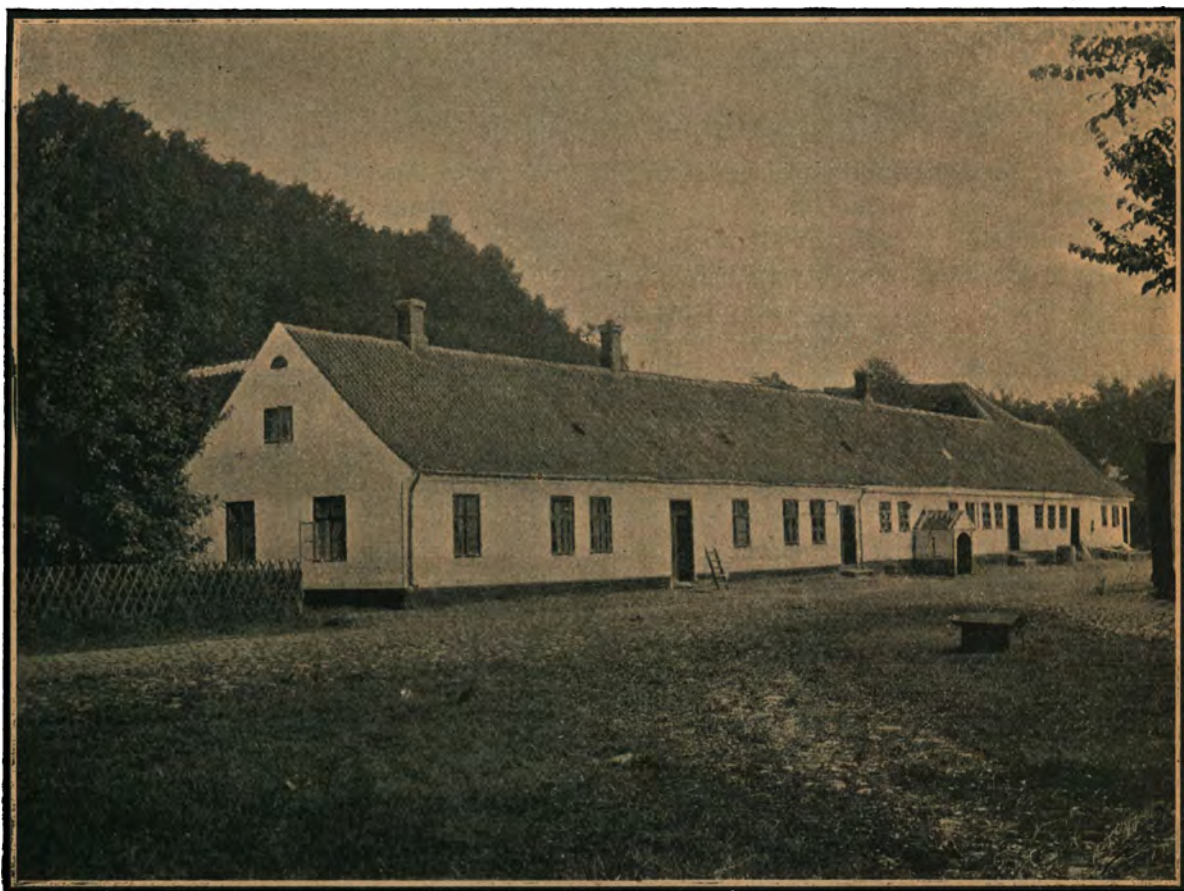
WALDBYGAARD FØR OMBYGNINGEN
