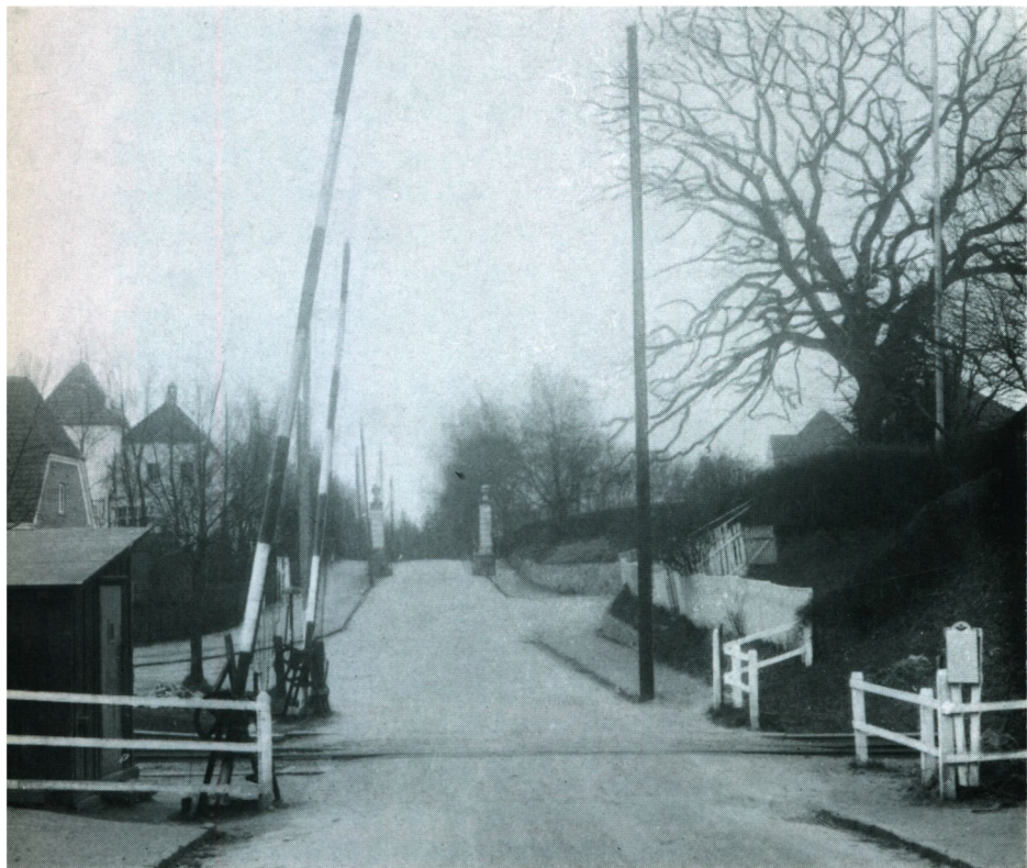
Jernbanebommen ved Dronninggårds Allé (passeret daglig på min skolevej i 8 1 / 2 år) o. 1920. Over taget på skuret til venstre ses murermester Chr. Petersens nye villa. I den store hvide villa bag ved denne boede, så vidt jeg da har forstået, filantropen Thora Esche (tilflyttet 1917).
