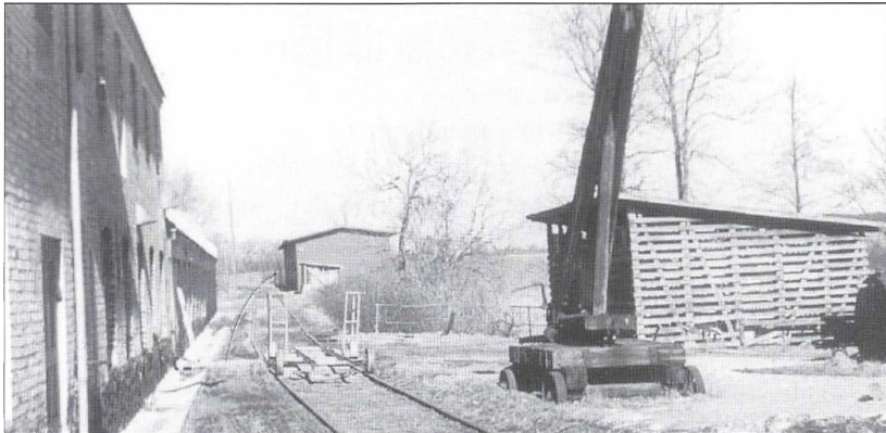
Sidesporet ned til fabrikken. Til højre står den manuelt betjente lossekran.
