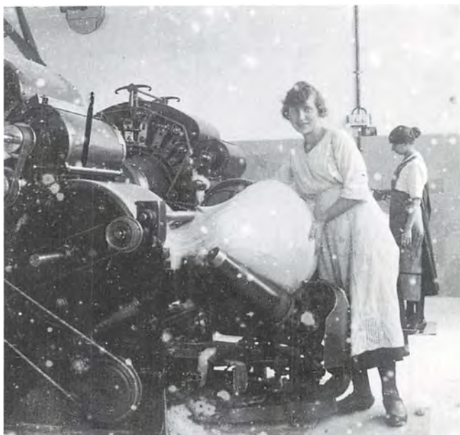
Kartemaskiner på Brede Klædefabrik (Hattefabrikken) ca. 1910. Kartefloret af uldfibre, der kommer ud af maskinen, bliver i dette tilfælde formet til en kegle, der senere skal presses i facon til en hat. Byhistorisk Samling, Lyngby-Taarbæk.
