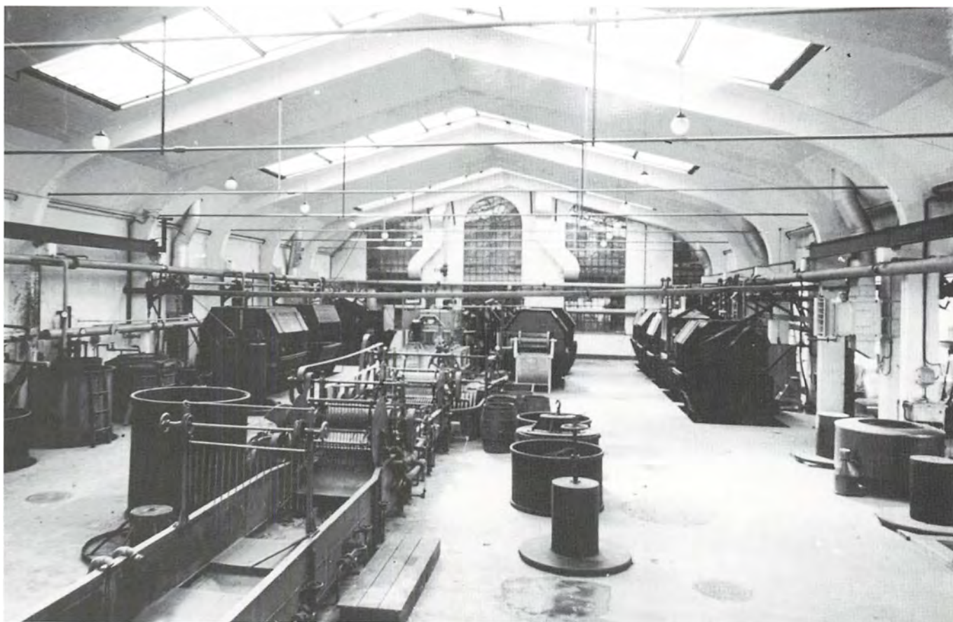
Interiør fra farveribygningen fra 1936, sandsynligvis fotograferet kort efter ibrugtagningen. Bag vinduerne i baggrunden (d. u.s. i bygning 6) fandtes vaskeriet. Maskinen i forgrunden er en uldvaskemaskine, en såkaldt Leviathan-maskine. Langs væggene i baggrunden ses stykfarvemaskiner. Byhistorisk Samling, Lyngby-Taarbæk.
