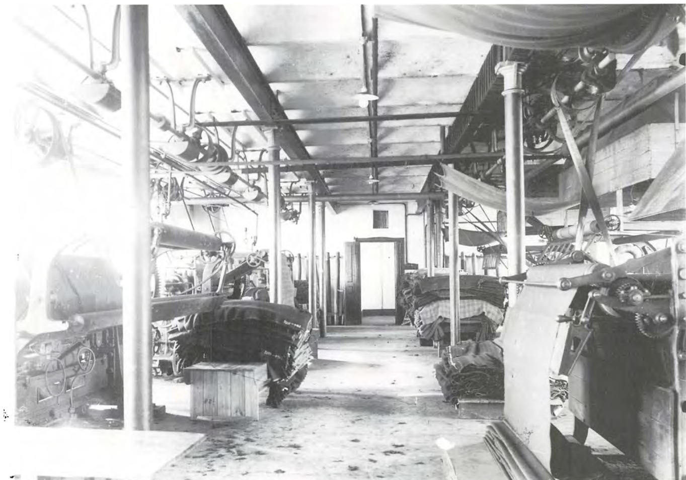
Interiør fra murstensbygningen fra 1890/1894, fotograferet i 1935. På dette tidspunkt anvendtes bygningen til efterbehandling af det særdige klæde, idet væveriet i 1920 var flyttet til en ny bygning. Maskinerne i forgrunden er til venstre en finishdekatermaskine, til højre en overskæremaskine. Bygningen har bærende søjler af støbejern, som er asymmetrisk opstillet, og loftet er udformet som korte murede buer. Byhistorisk Samling, Lyngby-Taarbæk.
