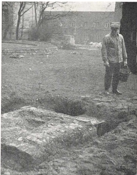
Udgravning af kirkefundament på Skt. Olufs Kirkegård 1947-48
