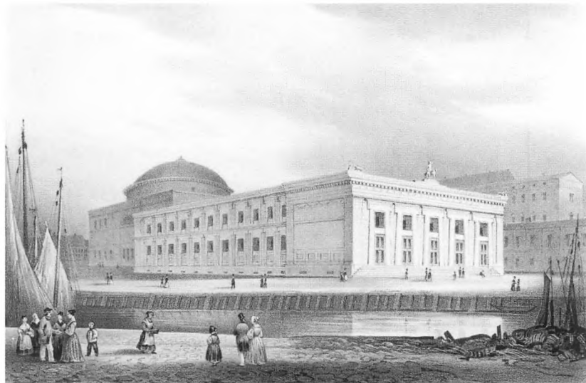
Det nyopførte Thorvaldsens Museum, set fra den anden side af kanalen. I baggrunden anes dele af det nyopførte Christianborg slot (C. F. Hansen) og Slotskirken.
