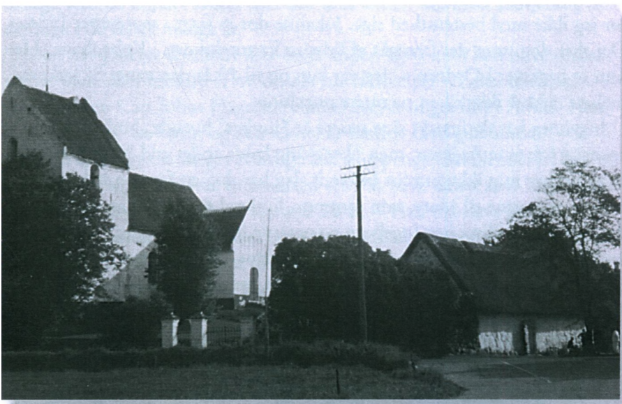
Kirken i Kirke Søby. Ældste del er fra den tidlige middelalder og opført af tilhugne kampesten. I sengotisk tid er det oprindelige kor nedrevet og skibet forlænget med endnu et krydshvalv. Kirken undergik i 1879 en uheldig renovering (Jf. Trap Danmark).
