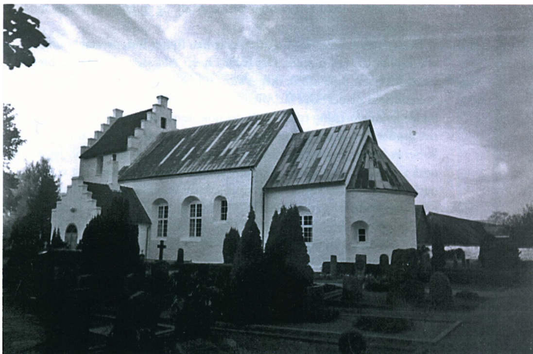
Sct. Peders Kirke i Pedersker, fra romansk tid, set fra sydøst. Skib, kor og apsis er oprindeligt opført af smukt tilhugne Cementsten. Tårnet er tilbygget senere - og af rå granit (Jf. Trap Danmark).
