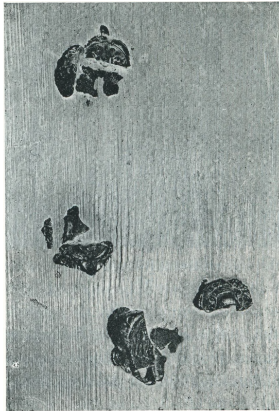
Fig. 24. Segltrester paa en Dør paa Clausholm.
