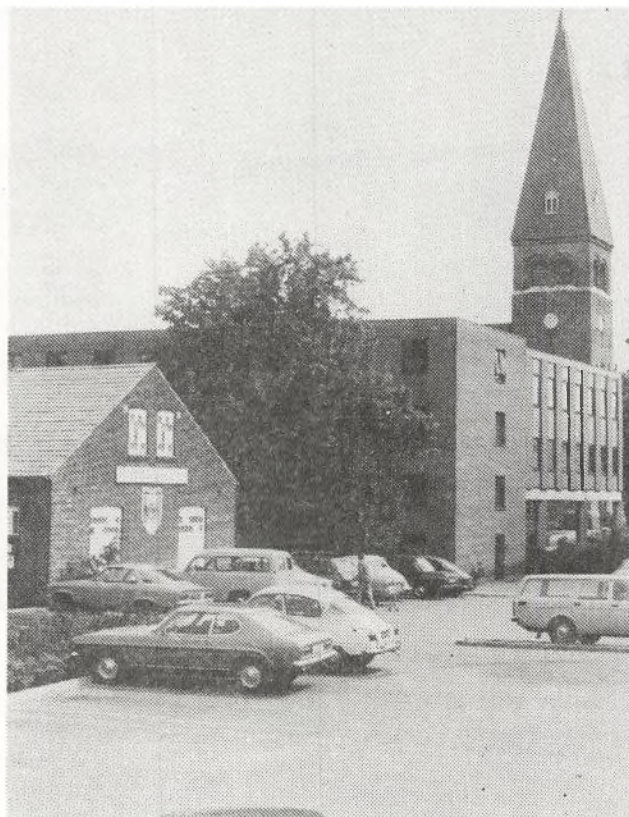
Dragonmusæet i Asylgade er indrettet 1959.
