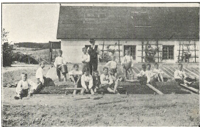
Ved Redskabshuset (opført af Drengene 1915).
