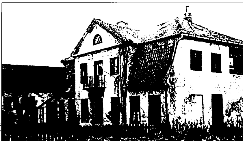
Grundtvigs virkelighed, Grundtvigs Højskole Marielyst, 1856. (Foto er fra nedrivningen 1953).
