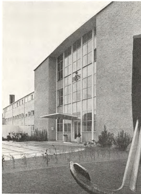
(Fotografi Søværnets Bygningsvæsen). Søofficersskolen paa Holmen. Indgangen paa Nordsiden.
