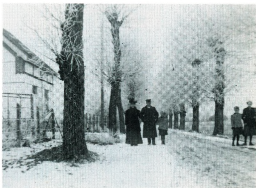
Teglovnsvvej. De første huse er bygget.
