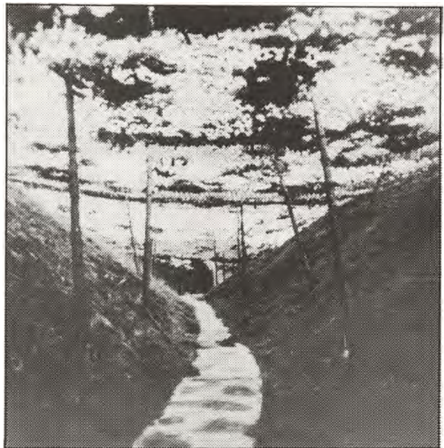
Sløret forbindelsesgang, Batteri Hanstholm I. (Foto Frede Koldsø.)
