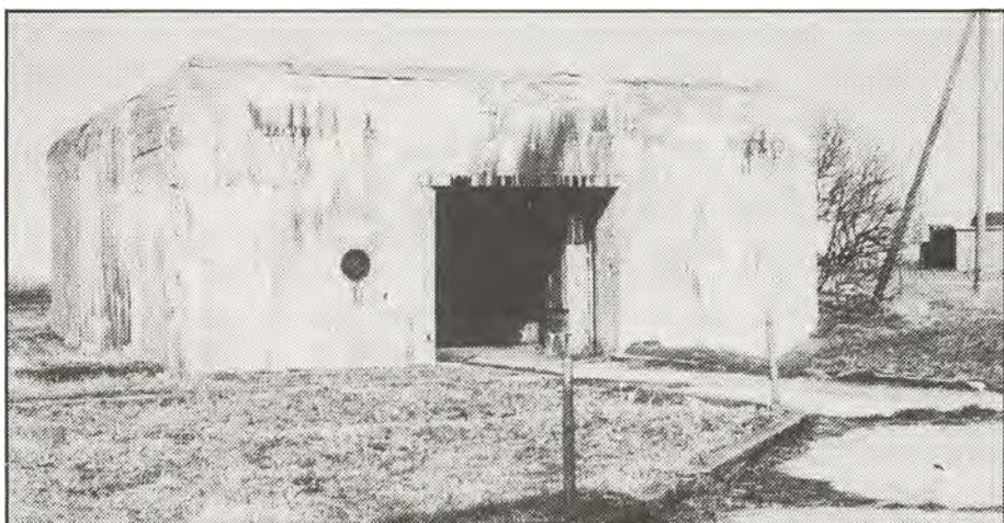
Kanonbunker, Batteri Tørring, Regelbau 669, med udkørselsmuligheder bagud for kanonen. (Fotos Knud Hendriksen.)
