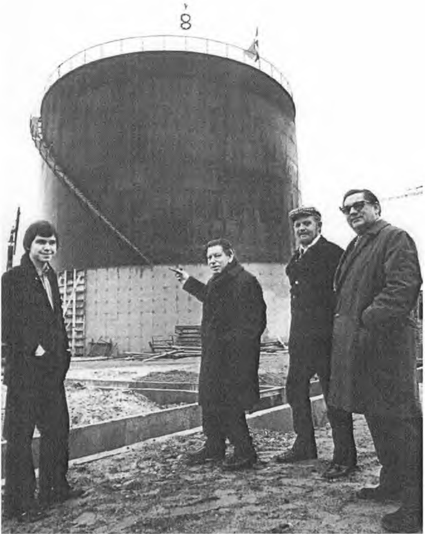
Rejsegilde på Thor-Oils olietank på Århus havn 7.november 1972. Fra venstre Kurt Thorsen, G.A.L. Thorsen, entreprenør Ove Jacobsen og direktør Svend Aage Jørgensen Foto: Børge Venge. Lokalhistorisk Samling i Århus.
