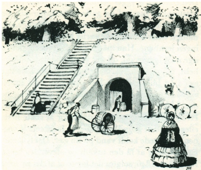
Udfaldsport i Københavns vold, brugt af J.C. Jacobsen som lagerkælder.
