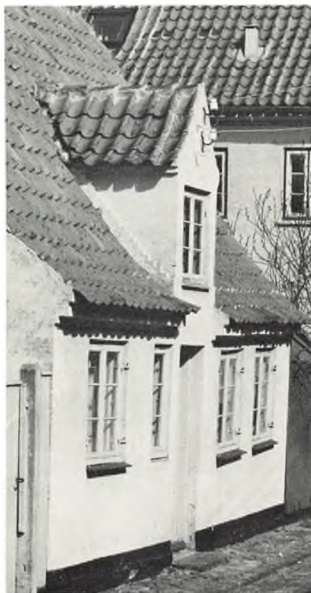
Von Ostensgade 8, sydfacade. (NM 1978).
