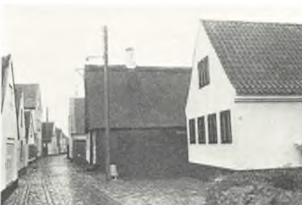
Skipperstræde 5, arkitekt John Freek Petersen og Strandstræde 33A. Begge opført før byplanvedtægt 2A, hvorved reglerne om sprosseinddeling ikke er gennemført. Bortset fra dette respekterer de begge miljøet i dimension og materialer.
