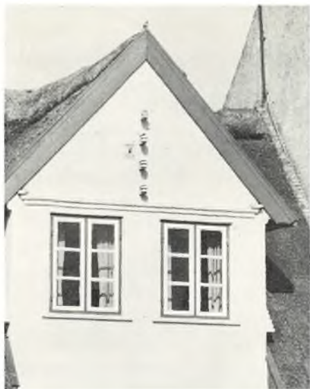
Strandgade 12, gavlkvist med gesimsbånd. (NM 1978).
