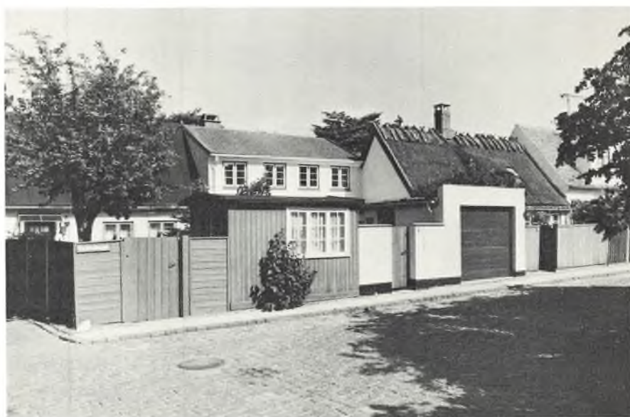
Vartovslængen 2-6, sydfacader. (NM 1977).
