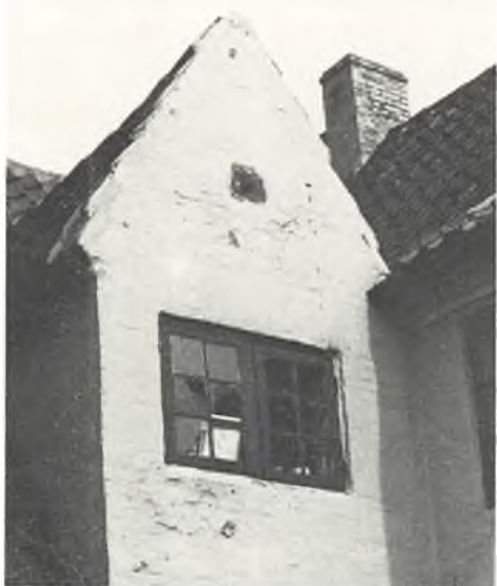
Gavl med indmuret »krubglas«, Dragør Kro. (Foto: 1972, Sv. Jans, DL).
