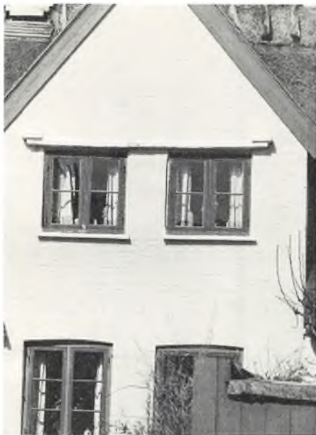
Strandgade 10, gavlkvist i syd med gesimsbånd. (NM 1978).
