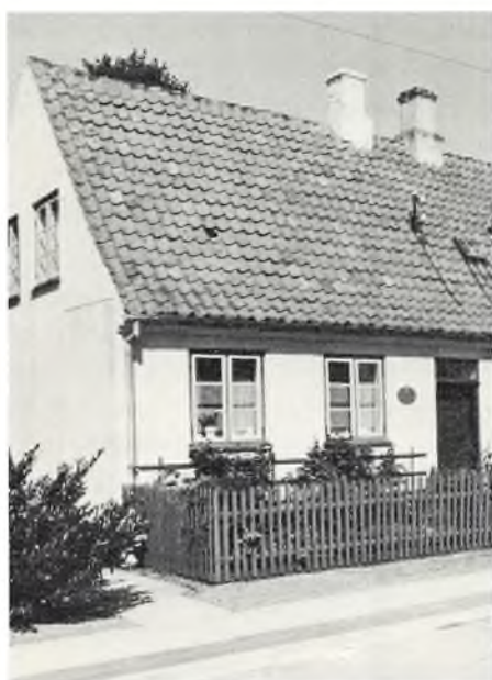
Nyby 3, østfacade. (NM 1977).
