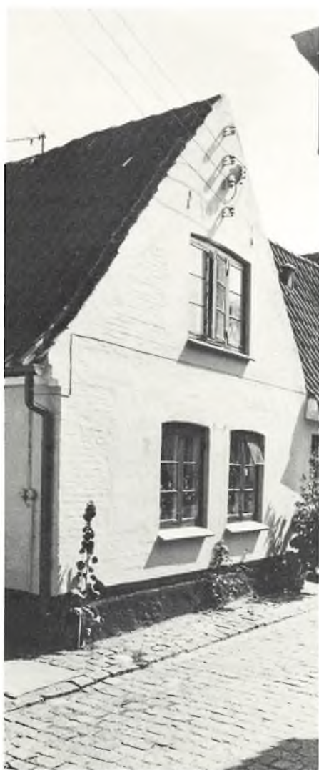
Skipperstræde 10, vestgavl af nordre bygning. (NM 1977).
