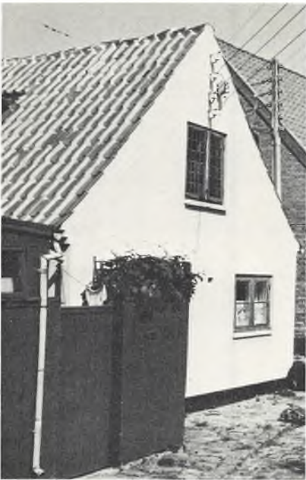
Lodsstræde 11, sydgavl. (NM 1977).
