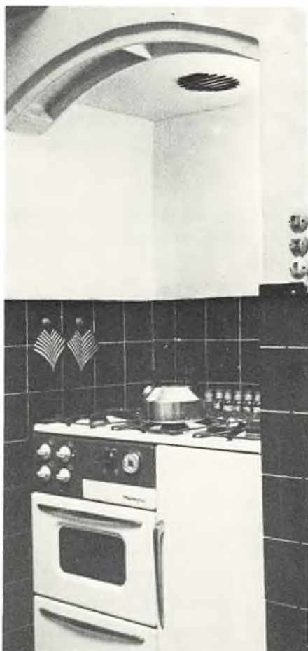
Åbent ildsted efter modernisering, Slippen 13. (Foto: Dirch Jansen).
