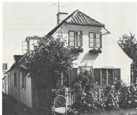
Vestgrønningen 10, vestgavl samt facade til Lillegade. (NM 1977).
