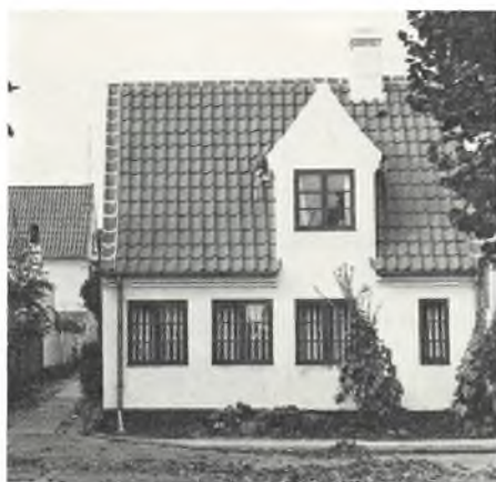
Øverst Hollandsfød 6, nederst Vognmandsgade 10. Begge de tidligere anonyme huse er ved ombygning forsynet med typiske Dragørkviste, i sidstnævnte hus er vinduesformaterne formindskede, arkitekt Jørgen Jensen.
