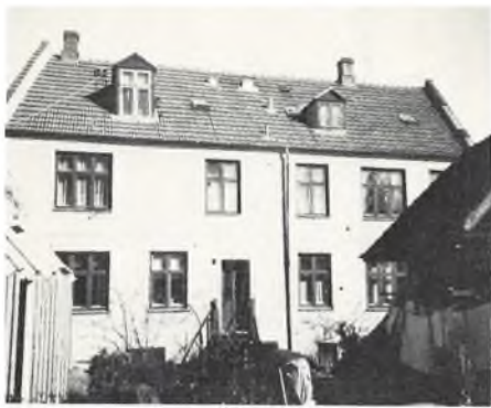
Den kommunale udlejningsejendom, Vestgrønningen 12. Ejendommen i grå cementsten gulkalkes og en gårdrydning skaber haverum.
