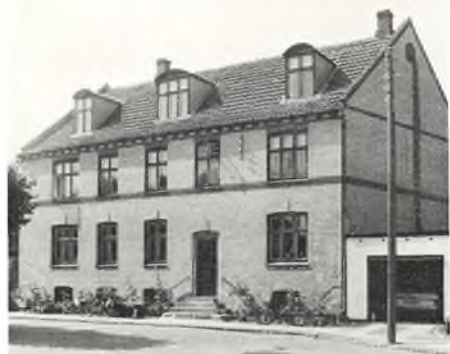
Vestgrønningen 12, bygning mod Badstuevælen før vandskuring og gulkalkning. (NM 1977).
