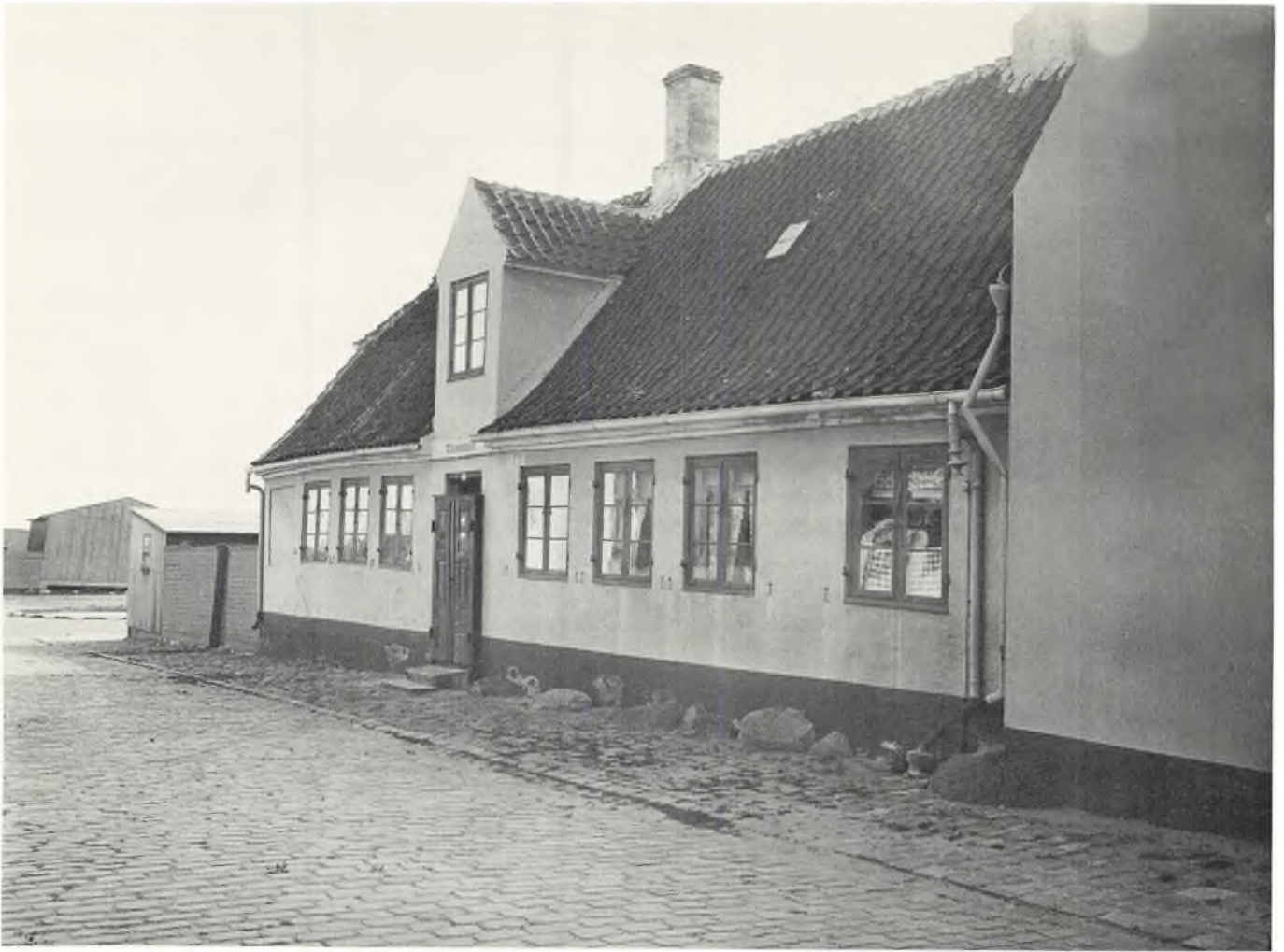
Zylfensgade 3, »Tulipanhuset«, nordfacade. (NM 1939).
