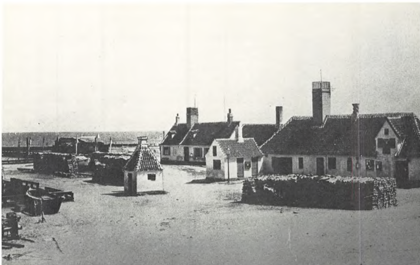
Dragør havn 1902, udsigtstårne på lodsstationen og på »byens hus«, nuv. museumsbygning. Sidstnævnte lårn nedrevet ca. 1910. På havnepladsen bagernes brændestakke. (Foto: DL).
