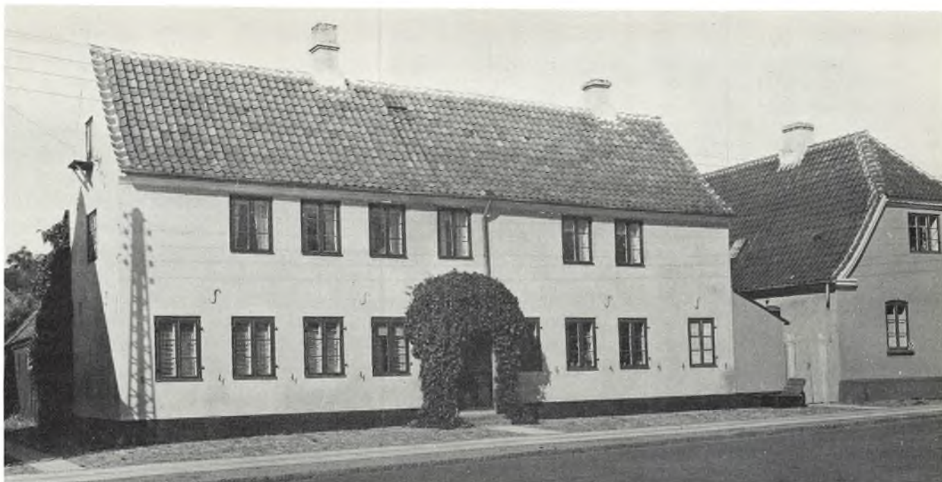
Vestgrønningen 3, østfacade samt gavl af nr.1. (NM 1939).
