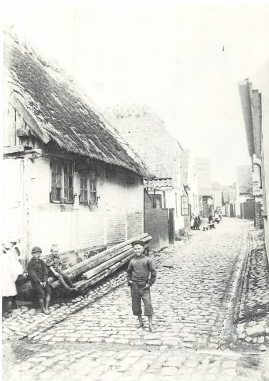
Strandstræde ca. 1904. Forreste bindingsværk har undtagelsesvis sidebånd. Af billedets 9 stråttækte huse har de 3 kragtræer, øvrige mønninger kan ikke nærmere identificeres. Andet hus tilvenstre har to skifter tagsten til sikring af tagskægget mod storm og fugle, der søger redemateriale. Denne detalje omtales første gang 1848 under en vurdering af Kongevejen 12. (Foto: DL).
