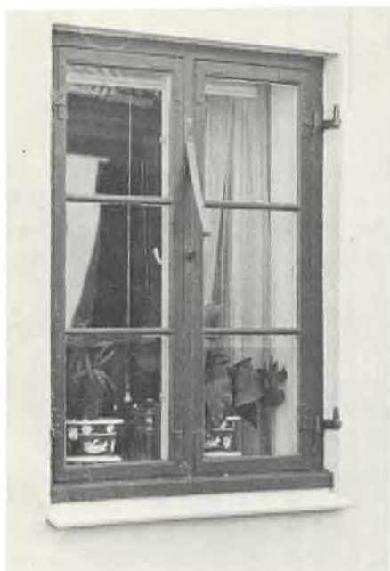
Von Ostensgade 9. Vindue i nordfacade med stabler til skodder og fjeder, som kan udløses indefra, hvorved skodderne springer op. (NM 1978).
