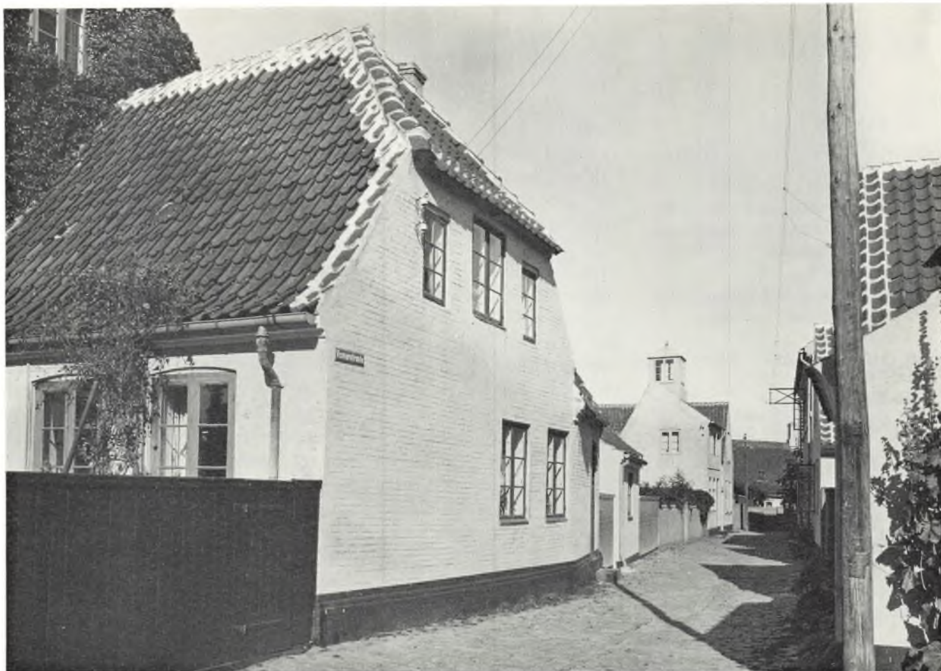
Wismarstræde set fra Kongevejen. I forgrunden t.v. Wismarstræde 2, der bag nr. 6 med senere nedtaget kikkenborg. (NM 1939).
