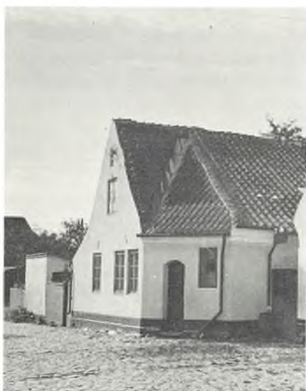
Byskriverstræde 7, østgavl samt ludebygning i nord. (NM 1939).
