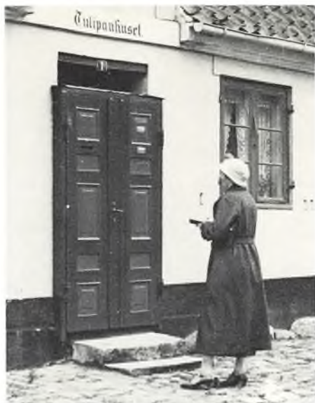
Vinterdør, Zylfensgade 3. (Foto 1958, 111).
