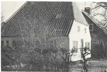
Engvej 6, opført i 1930'rne i Dragørstil.
