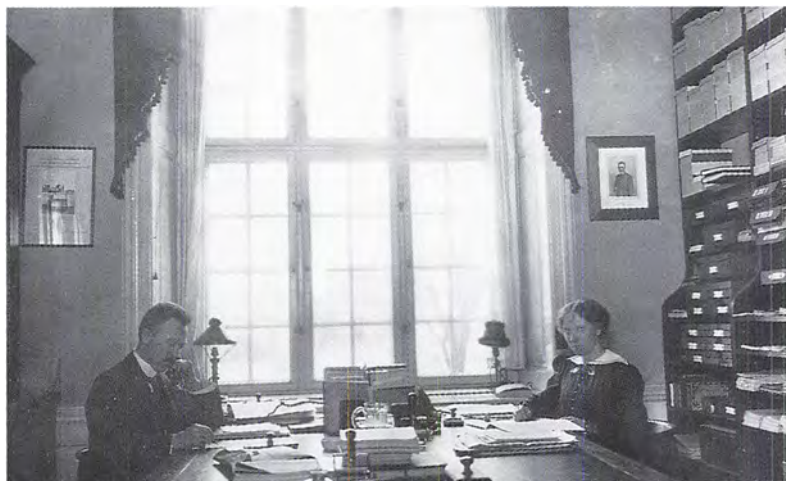
Kontor for Statens Planteavlsudvalg (oprettet 1898).
