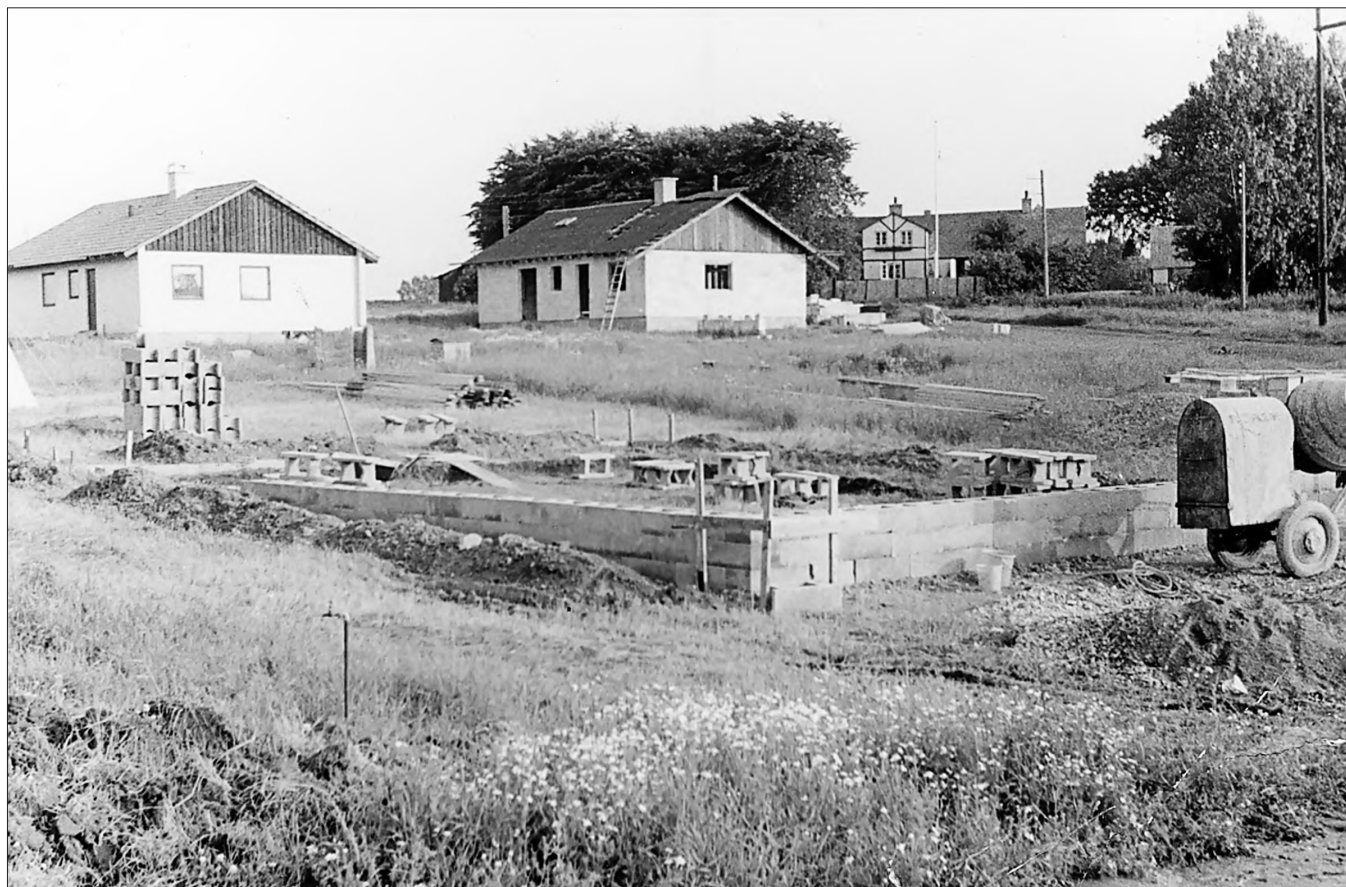
Byggeri på Nederkær med Stangkærgård i baggrunden. Privatfoto.
