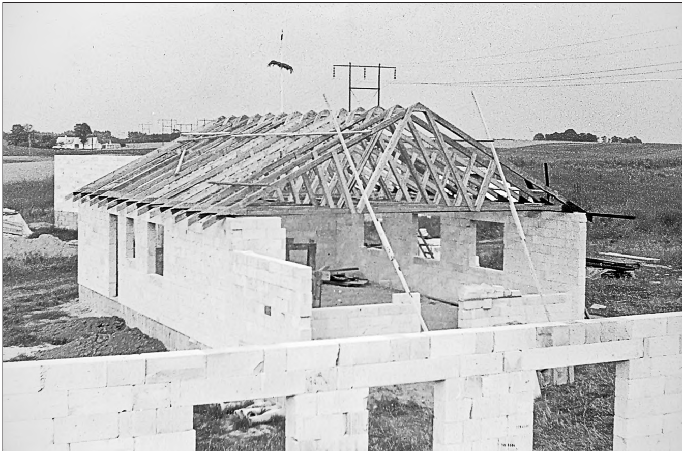
Rejsegilde på Børge Justesens hus, Nederkær 8. Privatfoto.
