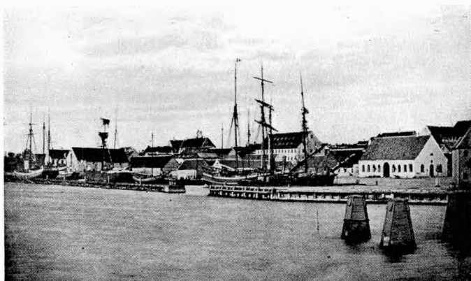
Havnen 1876 med Toldkammeret (bygget 1838)
