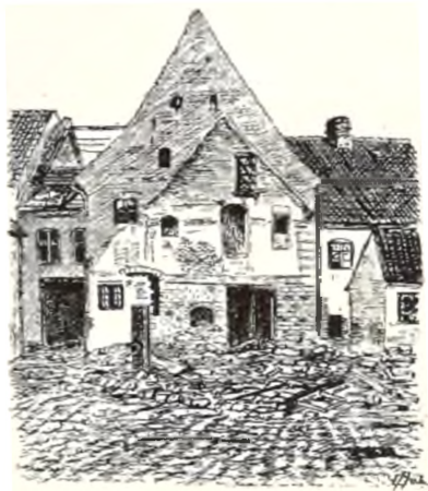
Stenhuset Østergade 17 under Nedbrydning, efter at en mindre Bygning er revet ned.
