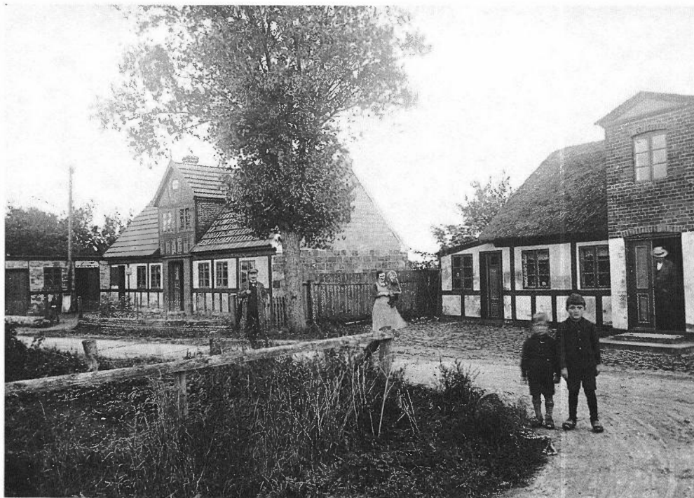
To af de gamle jordløse huse på Glud Kirkevej
