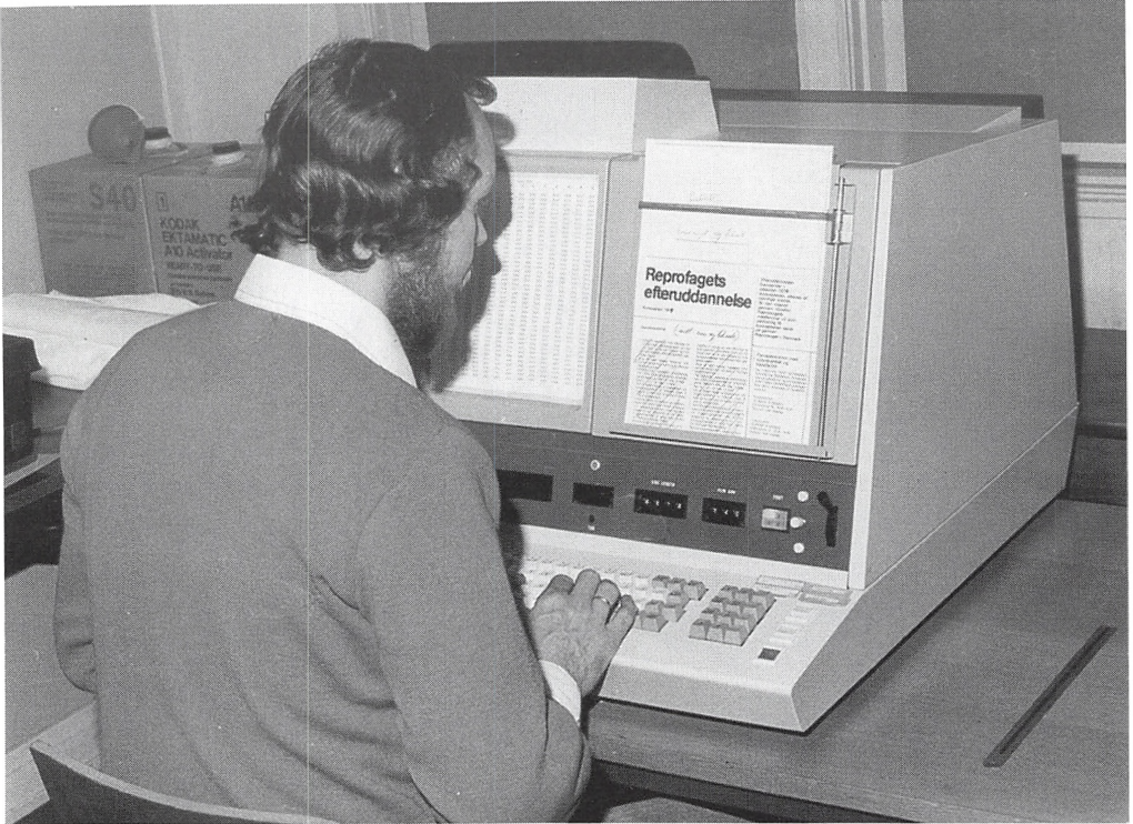
Reprografi. Billedet viser fotosættermaskine - forløberen for desktop-publishing-systemet. 1980erne.
