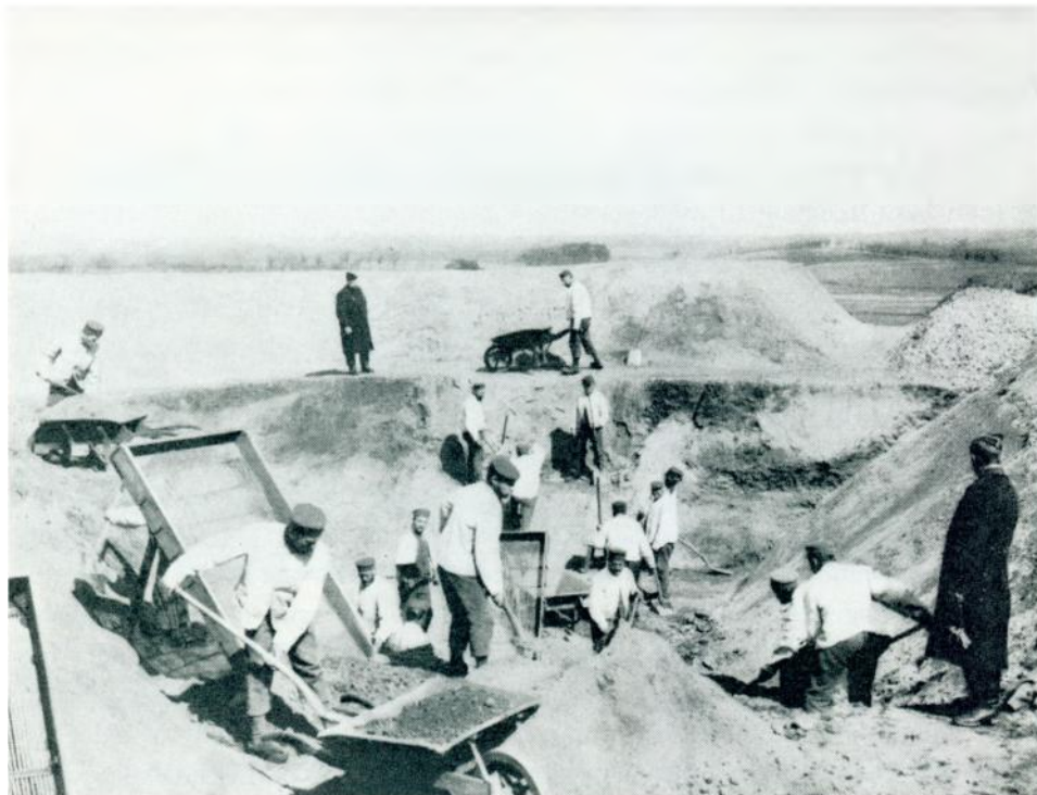
I Horsens begyndte man tidligt forsøgsvis at beskæftige fangerne med udendørs fælles arbejde, forberedelser til det endnu friere formede plantgearbejde ved Gedhus, Lem og Dejbjerg. – Fanger på arbejde i grusgraven ved straffeanstalten, foto i Kgl. Biblioteks Billedsamling.
